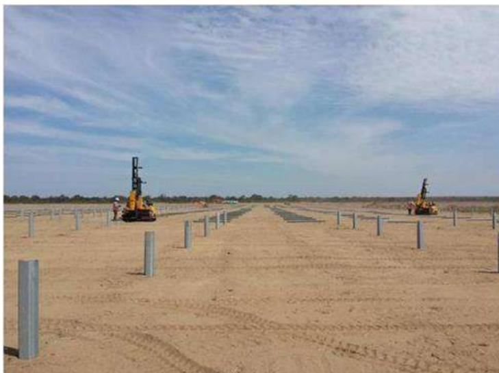
Figura 37. Fase di infissione dei pali con profilo omega (fonte Convert)
