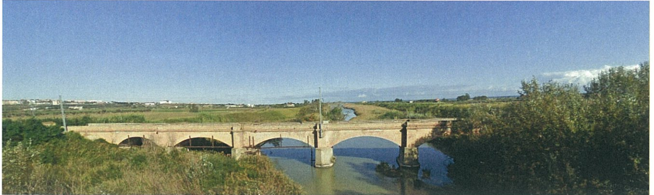
Foto 1 Fiume Biferno in corrispondenza dell'attuale tracciato ferroviario
