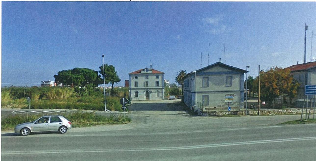
Strada di accesso al CA31
