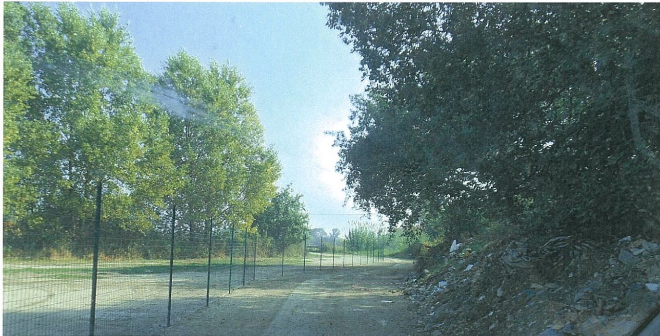
Strada di accesso all'area AT31
