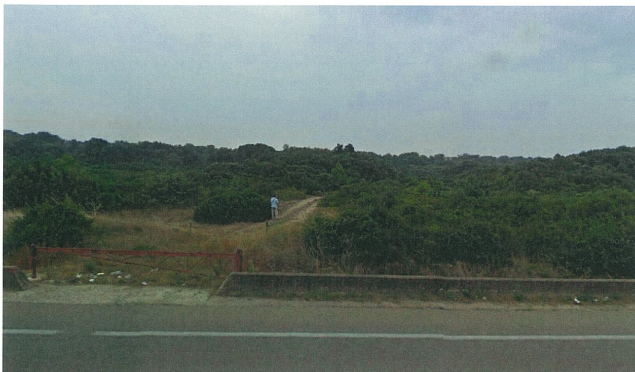
Foto 3 Strada non percorribile dai mezzi di cantiere in prossimità della AS33
