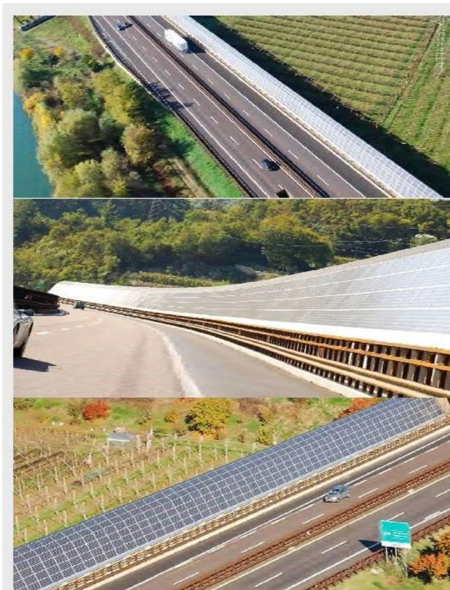
*Immagine ripresa dalle Linee Guida Parte 1 utilizza per indicare possibili soluzioni alternative agli impianti fotovoltaici a terra*
