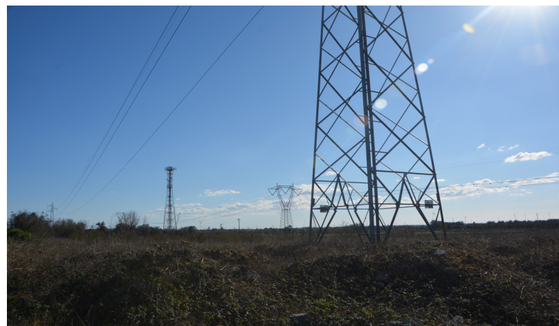
Fig. 4 L'area dell'impianto. Le linee e i tralicci dell'alta tensione. Vista da Sud
