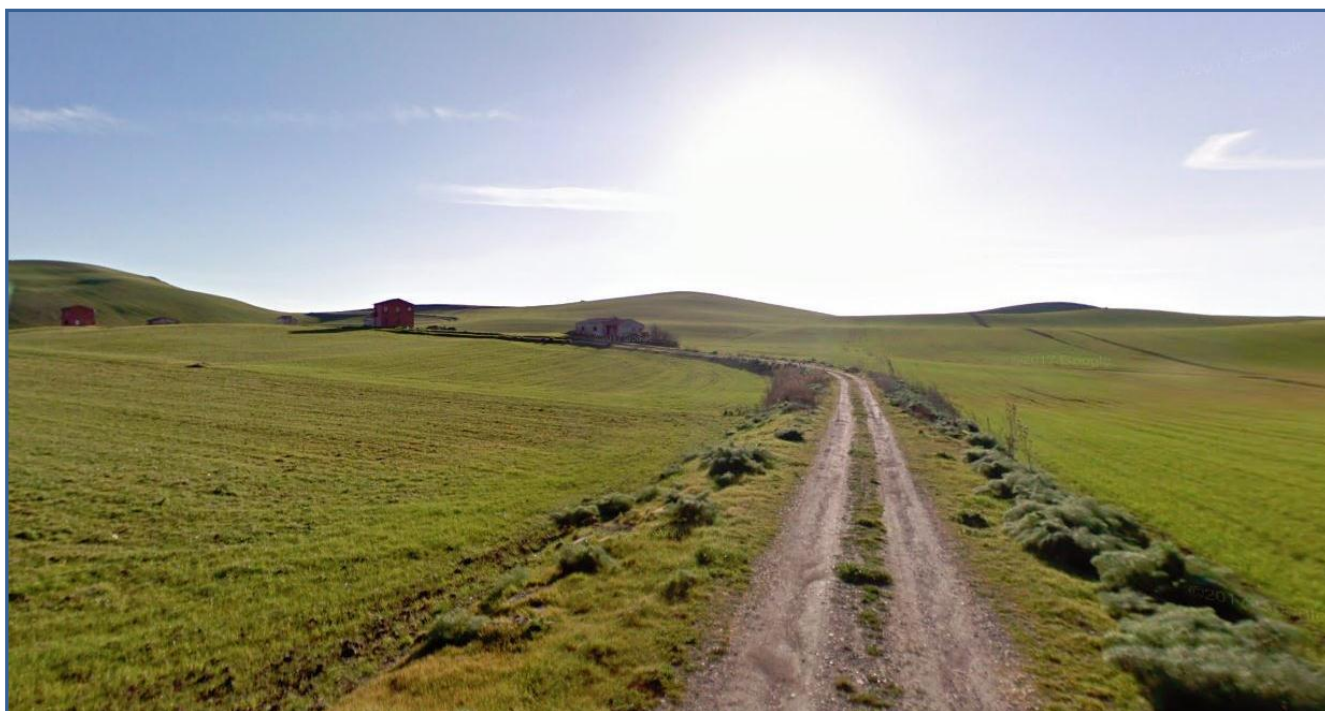
Figura 13 - Ripresa fotografica dell'area interessata dall'installazione degli aerogeneratori WTG 7, 8, 9, e della strada comunale in terra battuta lungo la quale verrà interrato il cavidotto interno di collegamento
