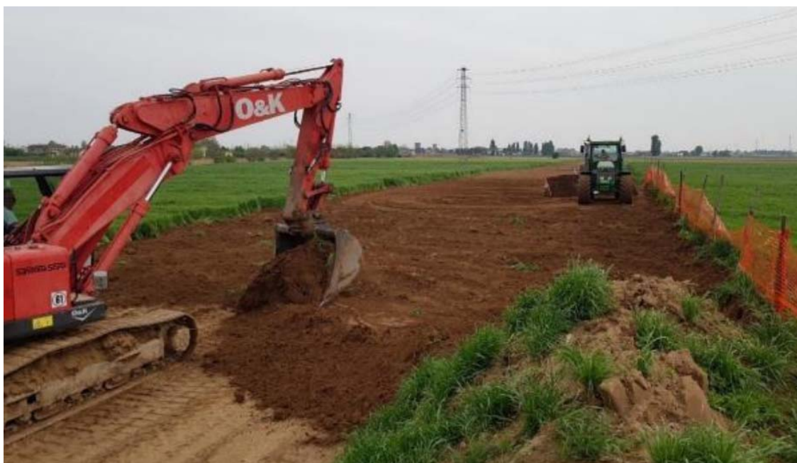
Foto 7.1.9/D - Distribuzione dello strato humico superficiale
