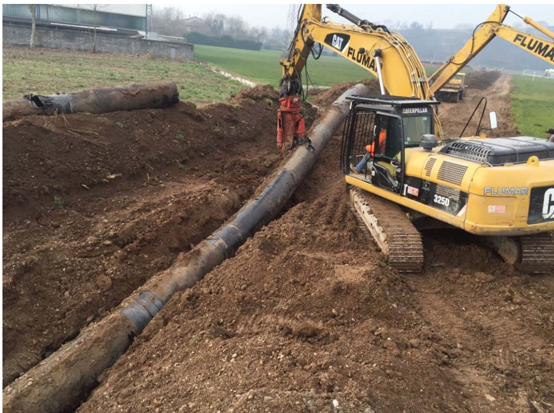
Foto 7.2.5/A - Sollevamento tubazione sezionata da rimuovere
