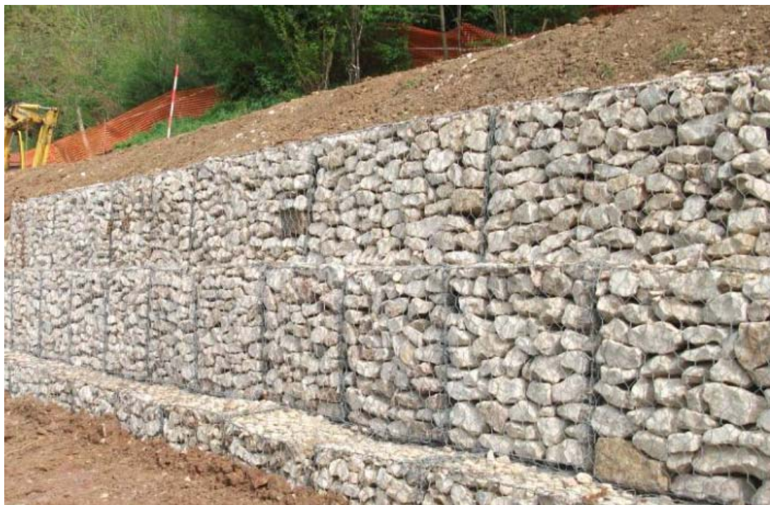
Foto 8.1.1/A – Muro gradonato in gabbioni
