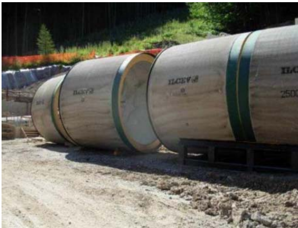
Foto 7.1.11/E - Stoccaggio tubi in c.a
