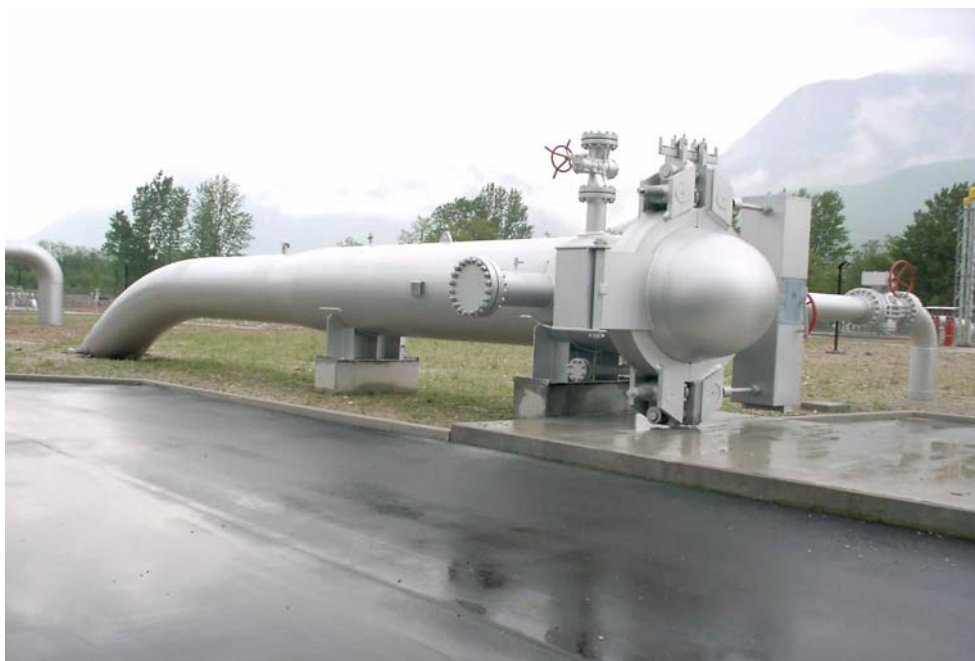
Foto 7.1.12/B - Punto di lancio e ricevimento pig
