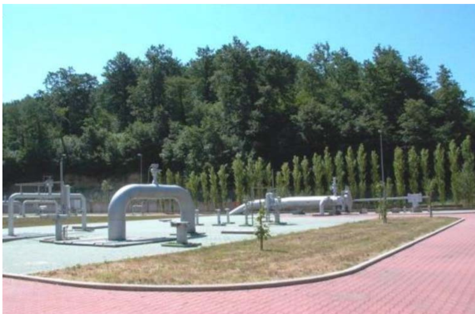
Foto 7.1.12/C – Allestimento area trappole
