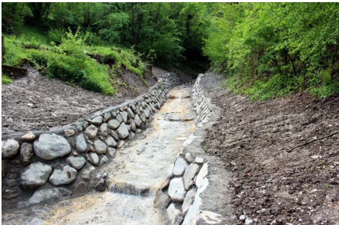
Foto 8.1.1/E – Regimazione di piccoli corsi d'acqua con cunetta in massi
