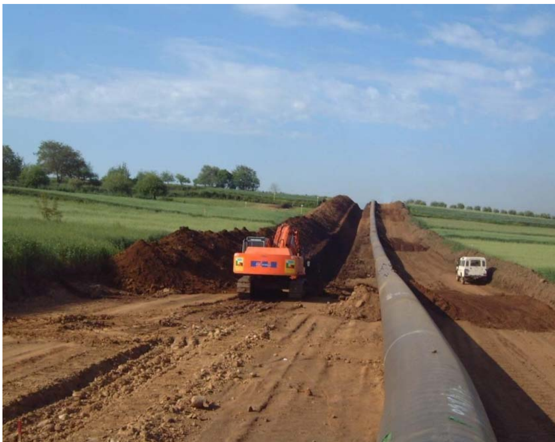
Foto 7.1.6/A - Scavo della trincea
