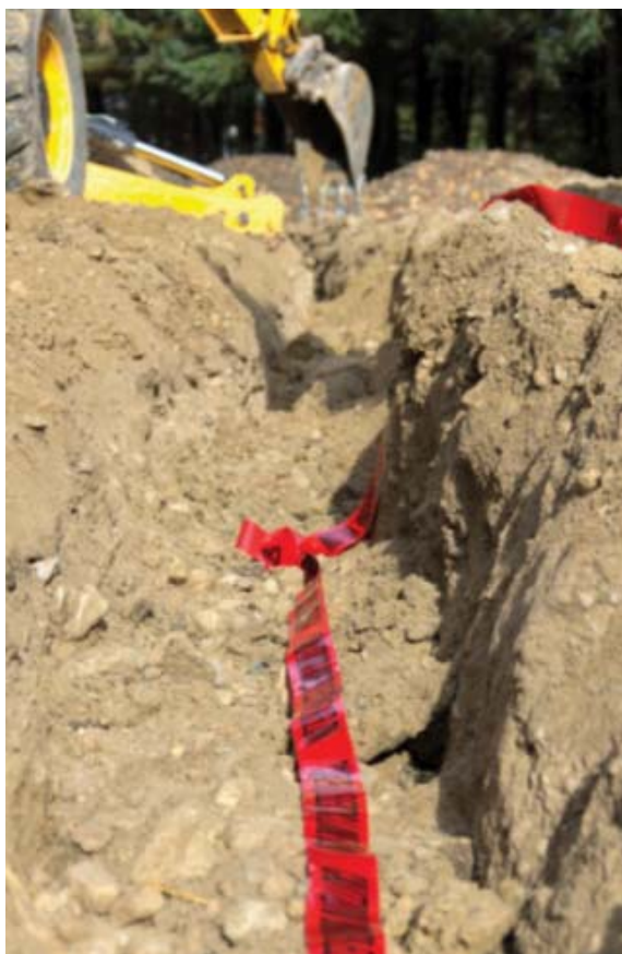
Foto 7.2.3/A – Scavo della trincea e rimozione del nastro di avvertimento
