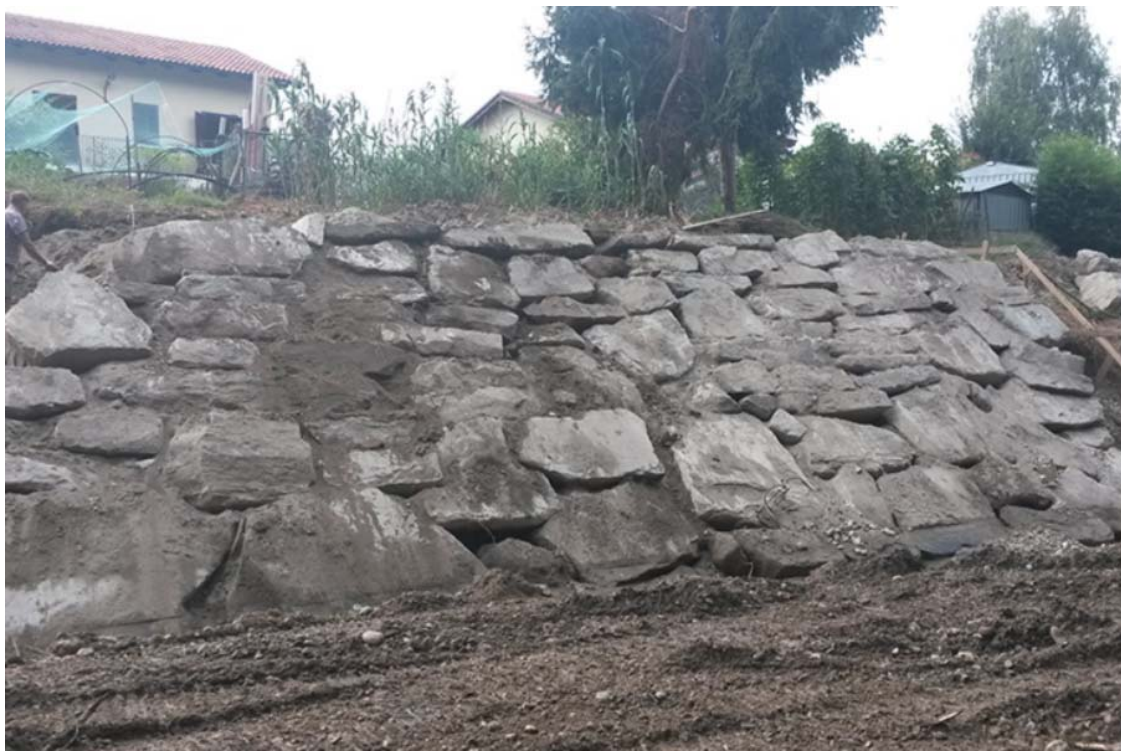
Foto 8.1.1/F – Rivestimento spondale in massi
