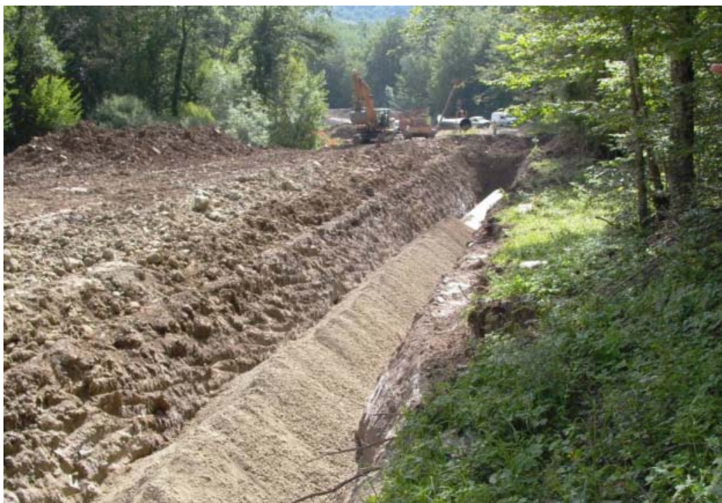
Foto 7.1.9/A – Pre-rinterro della condotta
