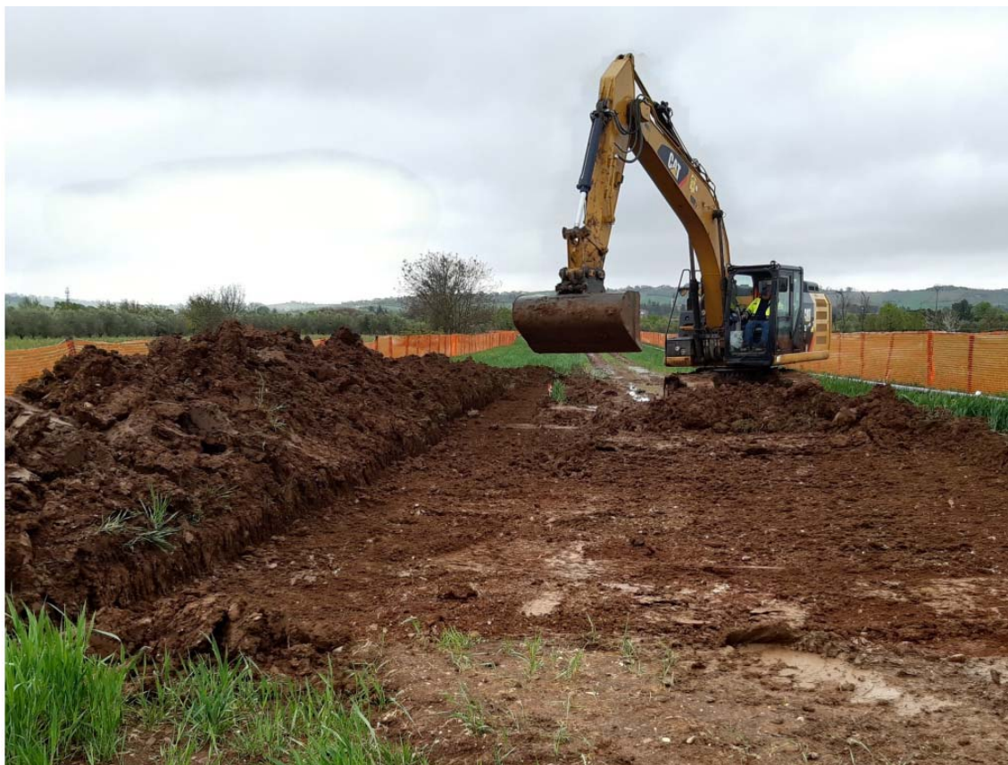
Foto 7.1.2/A - Apertura dell'area di passaggio con impiego di mezzi cingolati
