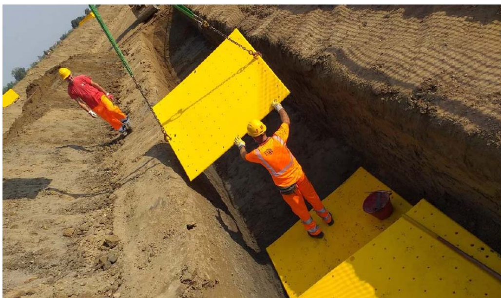
Foto 7.1.9/C - Rinterro della condotta e posa piastra di protezione HDPE
