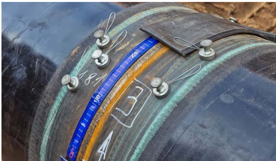
Foto 7.1.5/A - Controlli non distruttivi sulle saldature
