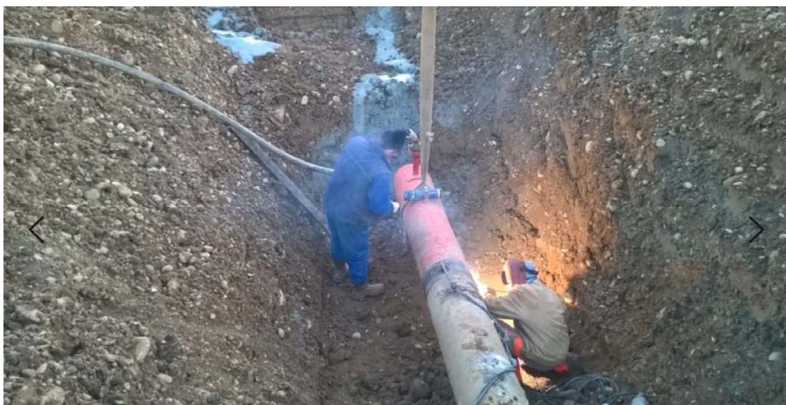
Foto 7.2.4/A – Sezionamento condotta
