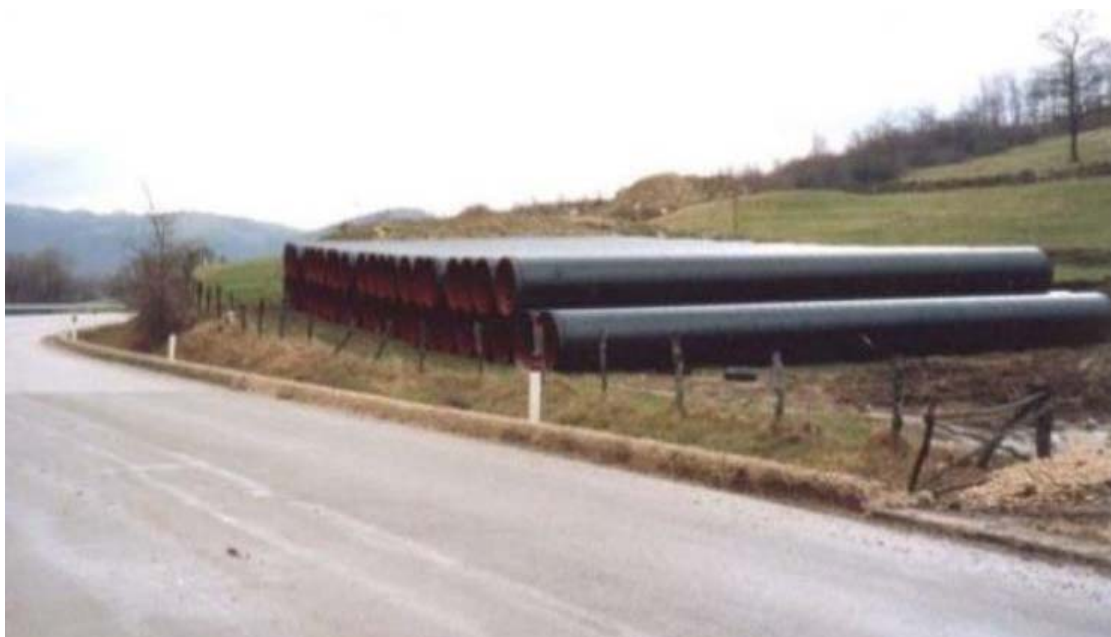
Foto 7.1.1/A - Piazzola di accatastamento tubazioni
