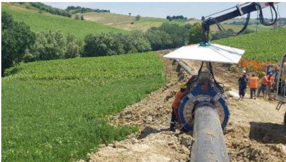
Foto 7.1.4/B - Saldatura automatica
