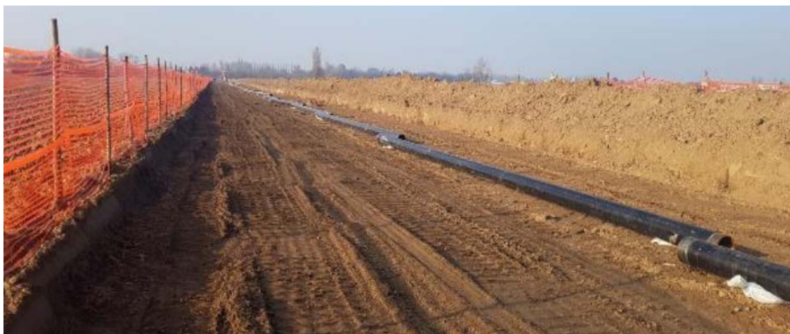
Foto 7.1.3/A – Sfilamento delle tubazioni di linea
