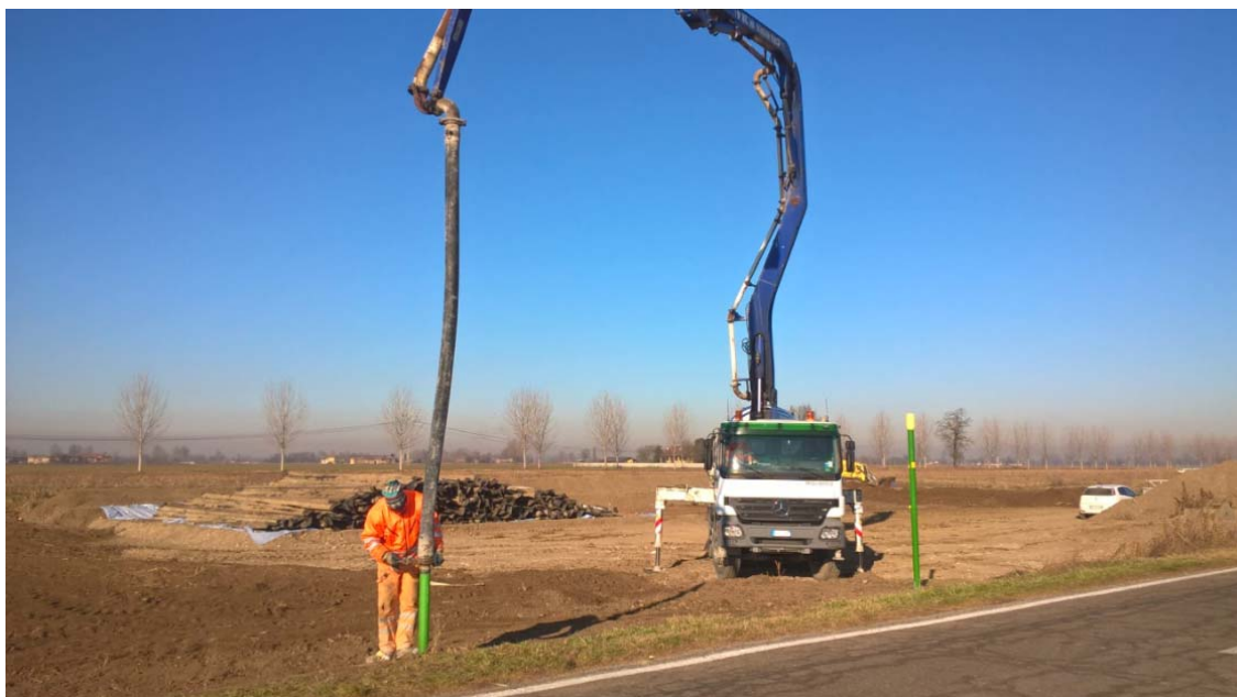
Foto 7.2.7/A – Inertizzazione del tubo di protezione
