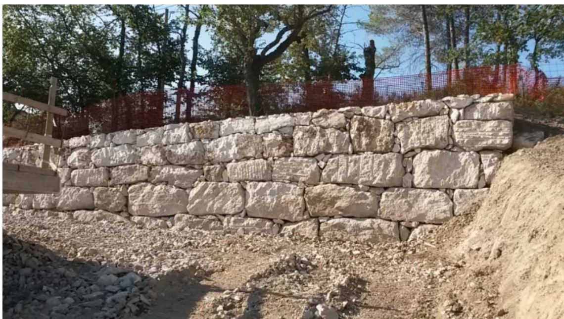
Foto 8.1.1/C – Muro di contenimento in massi
