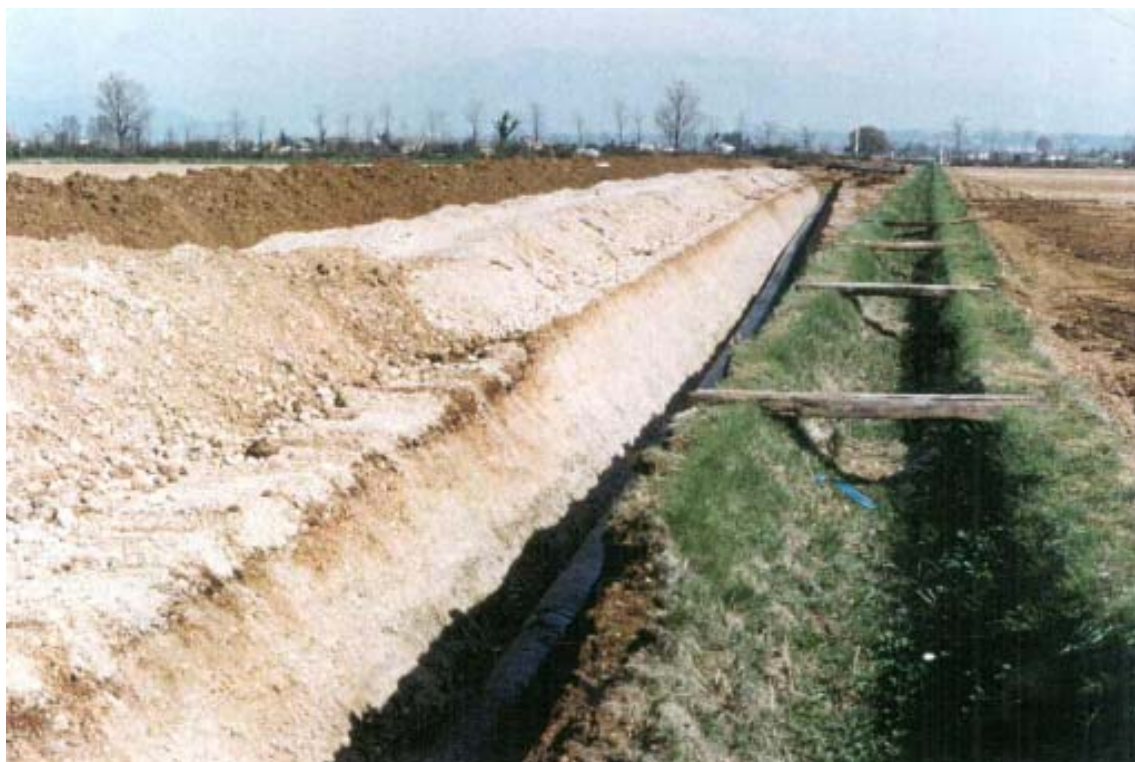
Foto 7.1.8/B - Tratto di condotta posata, con accantonamento dello strato humico separato dal materiale di scavo della trincea
