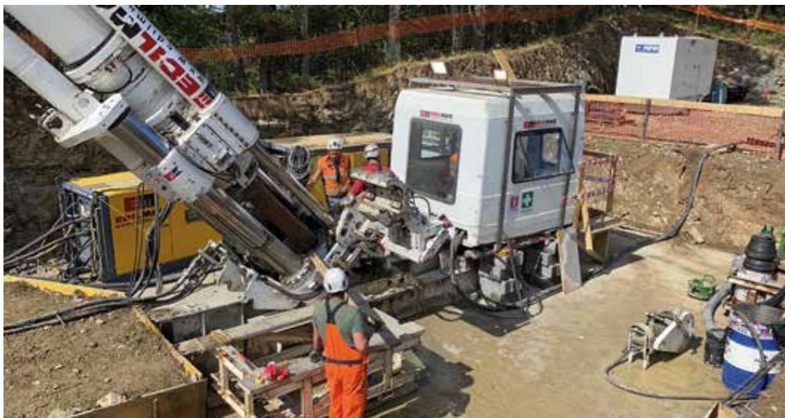
Foto 7.1.11/F - Esempio di stazione di perforazione per raise borer
