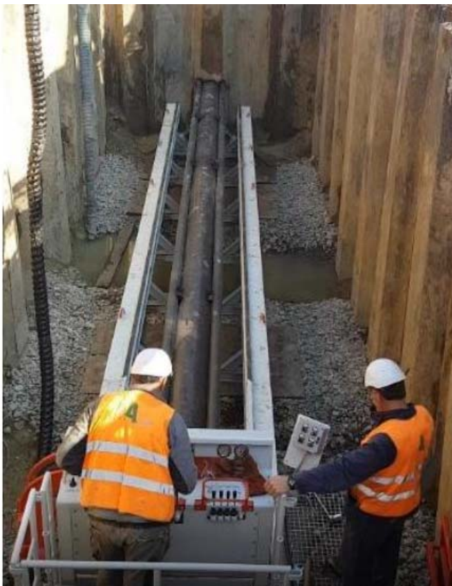
Foto 7.1.10/A - Trivellazione con spingitubo
