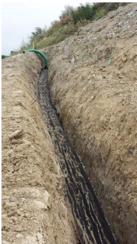
Foto 8.1.1/I – Trincea drenante sotto condotta
