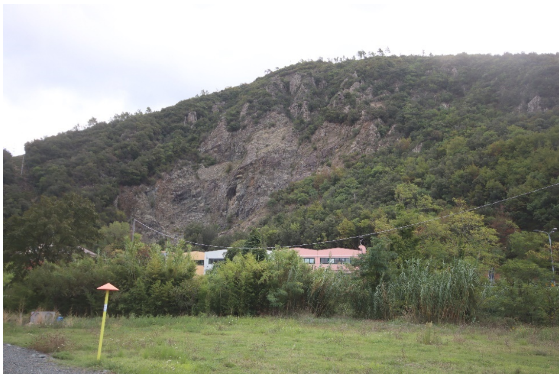
Foto 6.3.3/D1 - Cava dismessa alle pendici dei rilievi collinari che si sviluppano lungo Torrente Petronio a monte di Borgonastro
