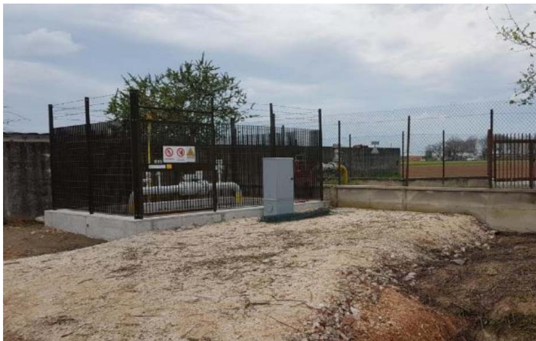
Foto 12.1/A - Esempio di punto di intercettazione al termine dei lavori
