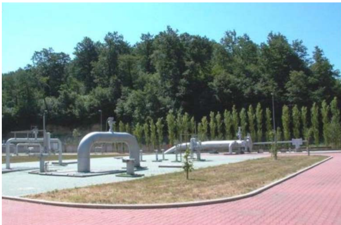
Fig. 12.1/B – Esempio di area trappole al termine dei lavori
