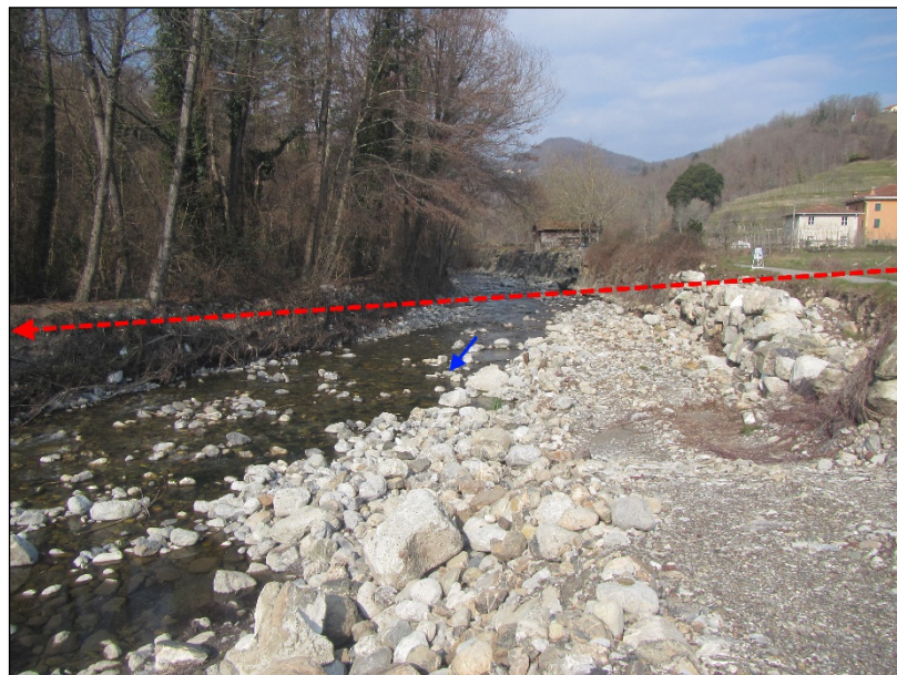
Fig. 6.4/A - Foto ambito d'attraversamento in microtunnel
