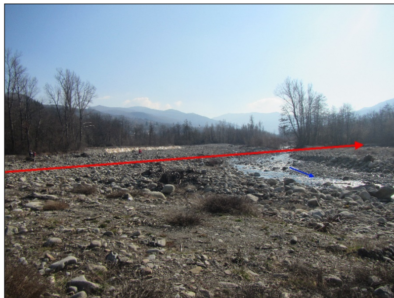
Fig. 5.4/A - Foto ambito d'attraversamento con scavi a cielo aperto
