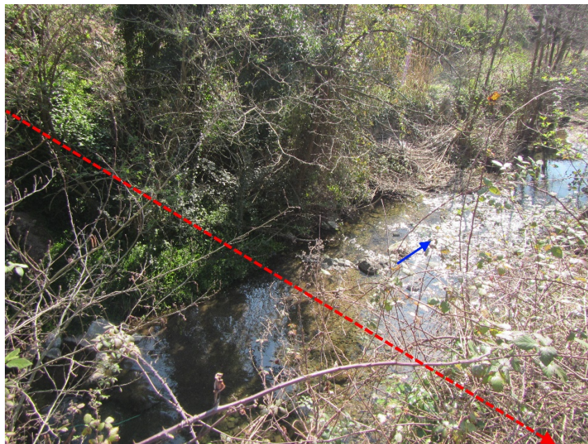
Fig. 7.3/A - Foto ambito d'attraversamento in microtunnel
