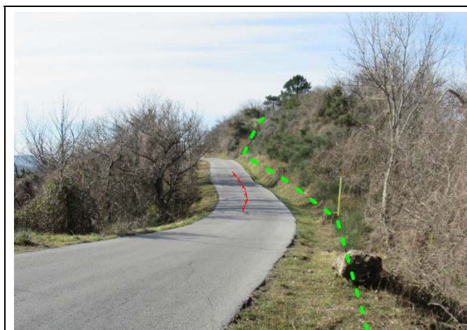
Fig. 4.8/C: Attraversamento dell'area P3. In verde a tratto il Metanodotto Derivazione per Sestri Levante in dismissione, in rosso le fratture di trazione.
