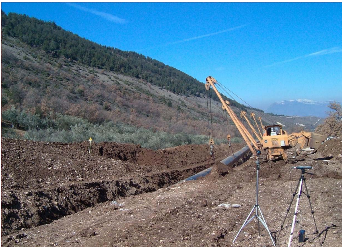
Fig. 4.1/A Esempio di posa di una condotta con trattori posatubi
