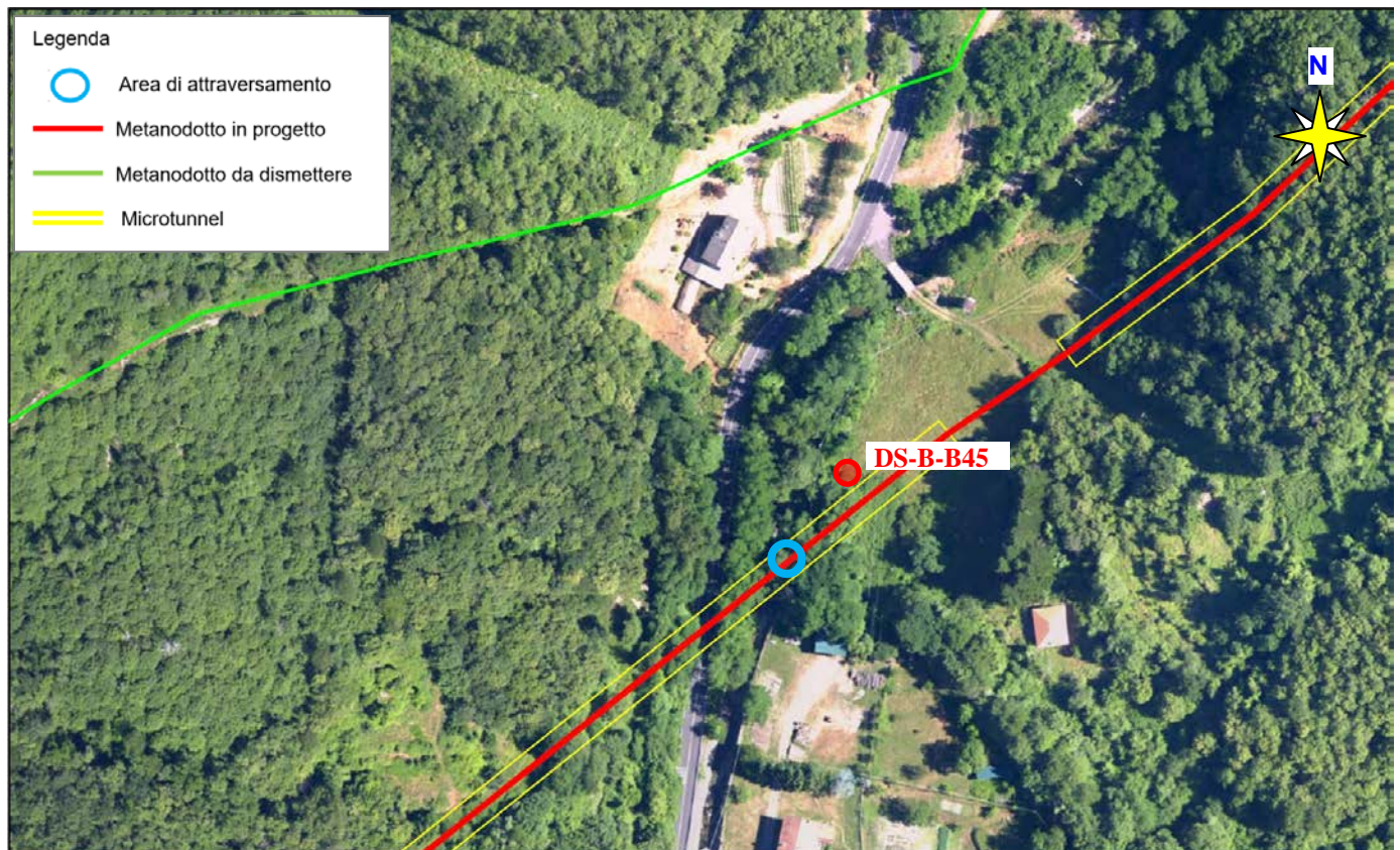
Fig.3.3/A: Foto aerea dell'ambito di attraversamento, con ubicazione del sondaggio di interesse
