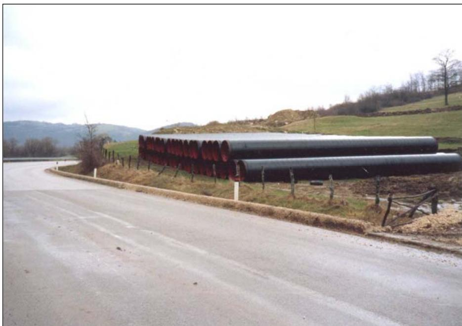
**Figura 2: Esempio di piazzola di accatastamento tubazioni**
