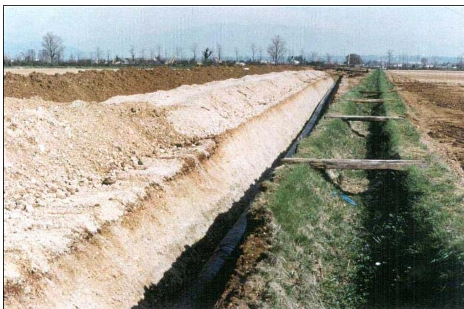
**Figura 11: Tratto di condotta posata, si nota l'accantonamento dello strato humico separato dal materiale di scavo della trincea**
