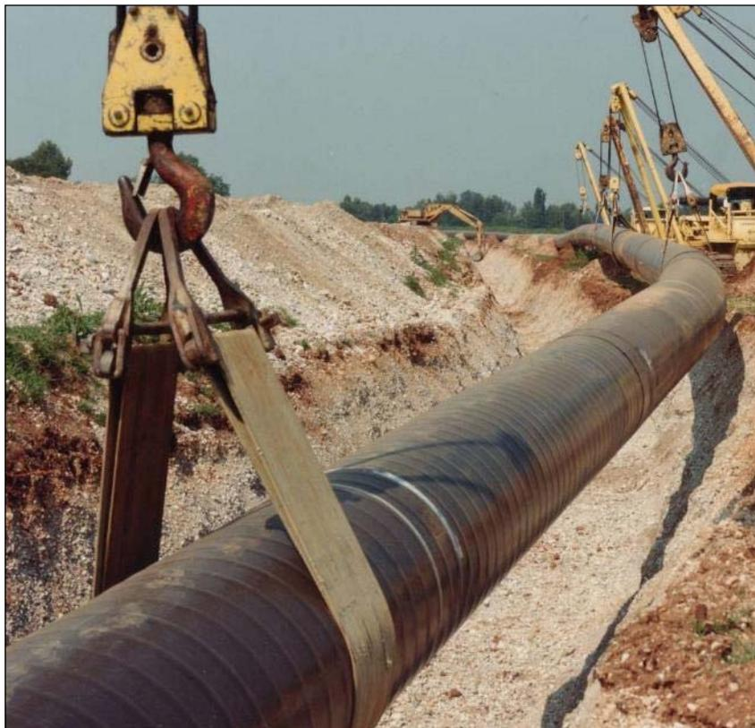
**Figura 10: Posa della condotta (esempio di condotta con diametro superiore alla linea in progetto)**
