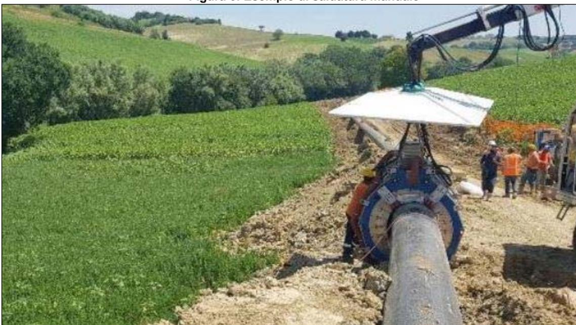
**Figura 7: Esempio di saldatura automatica**
