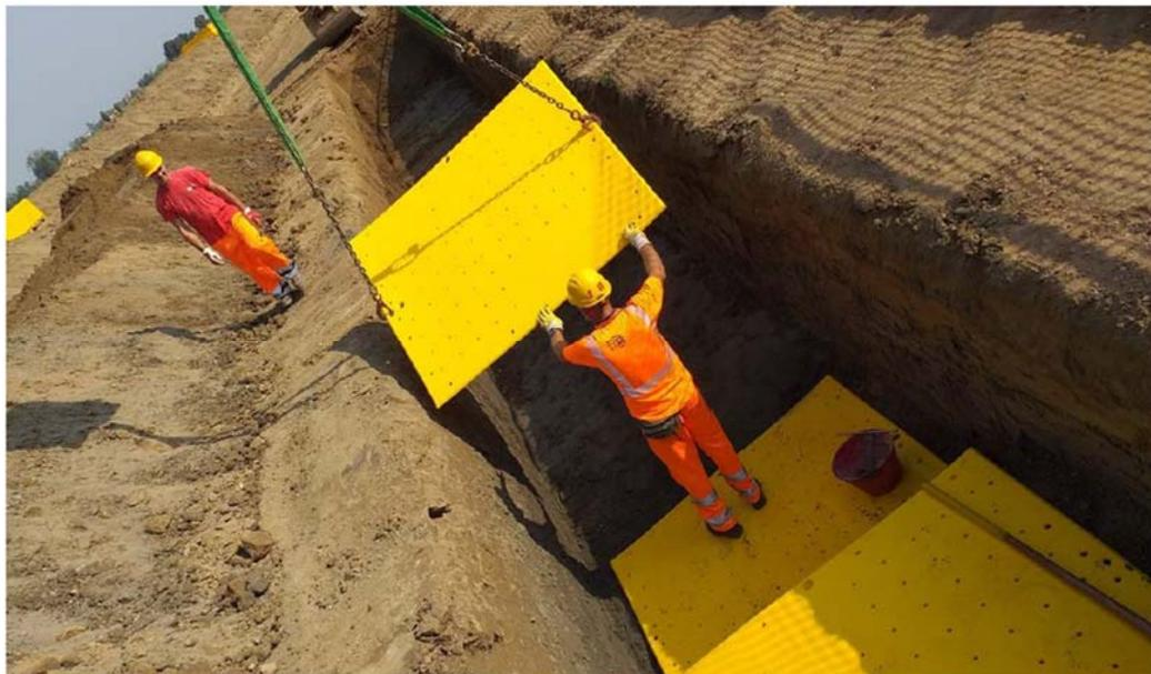
**Figura 13: Rinterro della condotta e posa piastra di protezione HDPE**
