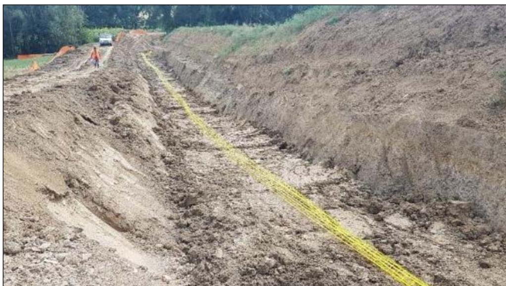
**Figura 12: Rinterro della condotta e posa del nastro di avvertimento**
