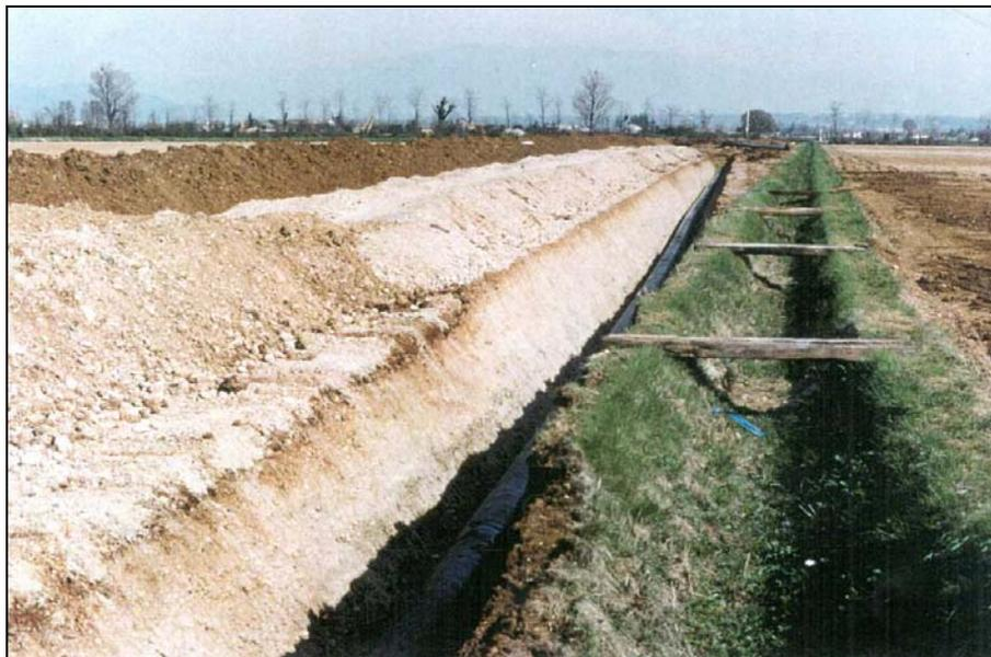
**Foto 5/I - Tratto di condotta posata, si nota l'accantonamento dello strato humico separato dal materiale di scavo della trincea**
