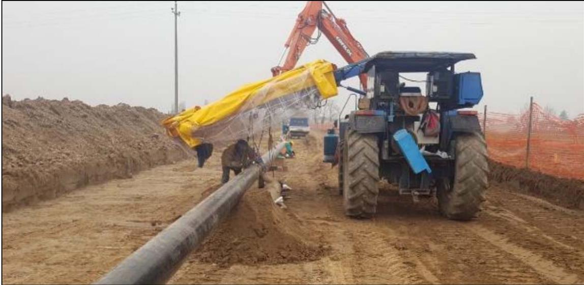
**Foto 5/E - Esempio di saldatura manuale**
