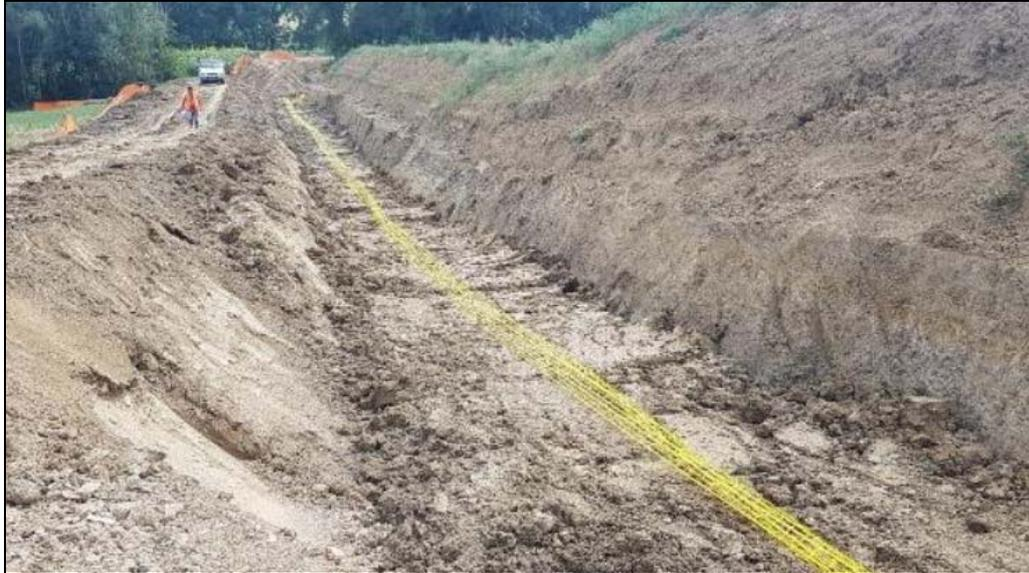
**Foto 5/L - Rinterro della condotta e posa del nastro di avvertimento**
