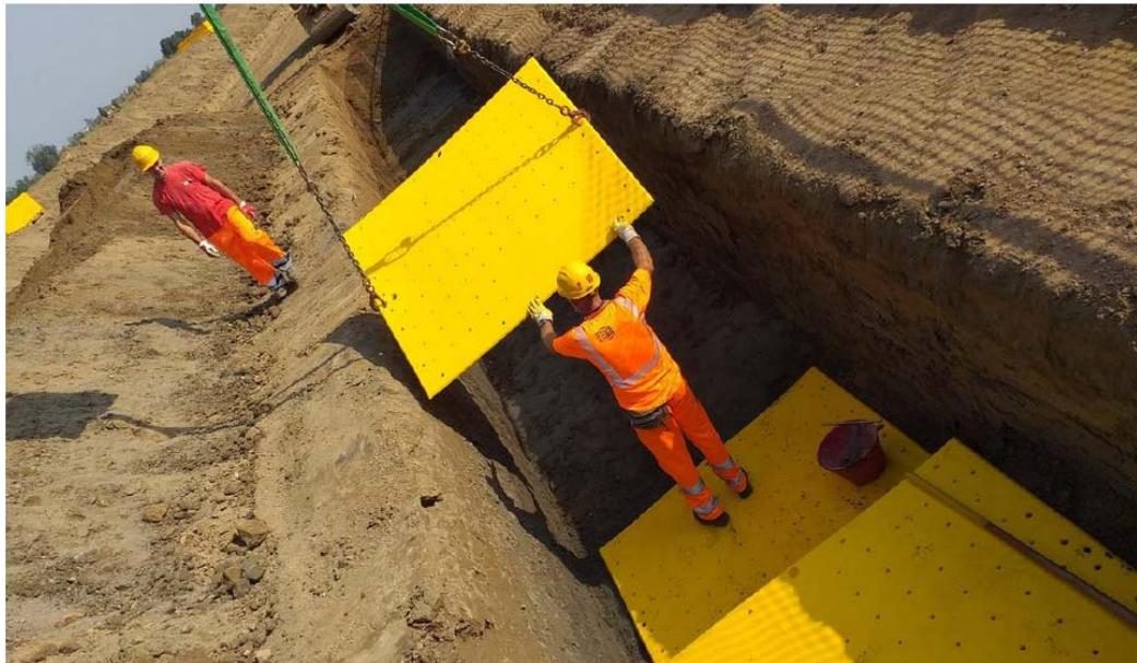
**Foto 5/M - Rinterro della condotta e posa piastra di protezione HDPE**
