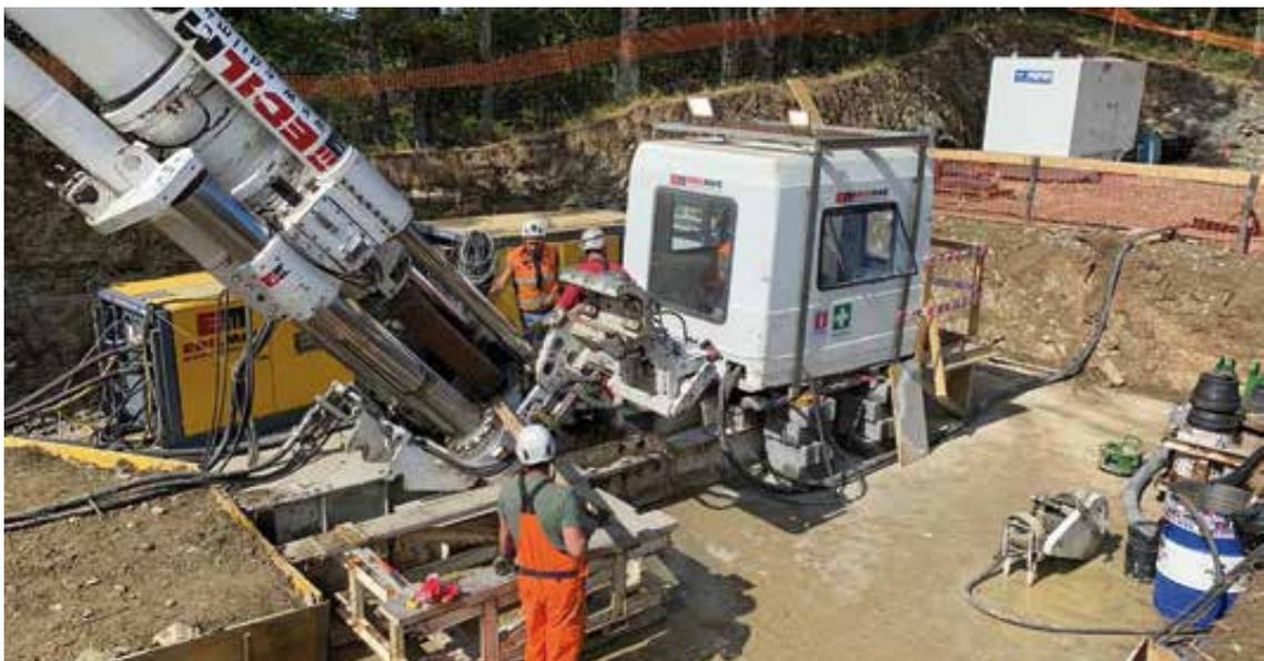
**Foto 5/R - Esempio di stazione di perforazione per raise borer**
