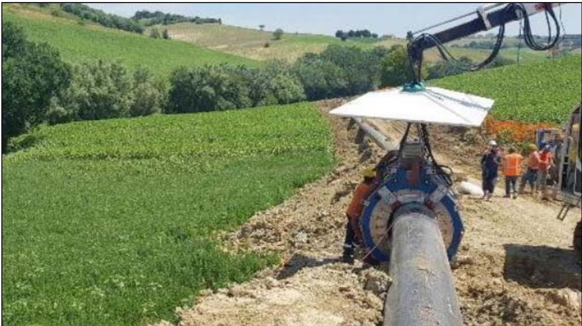
**Foto 5/F - Esempio di saldatura automatica**
