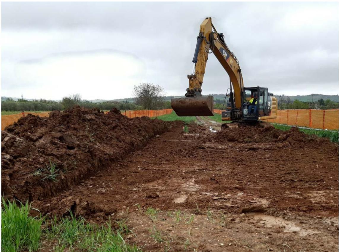
Foto 5/B - Apertura dell'area di passaggio con l'impiego di mezzi cingolati
