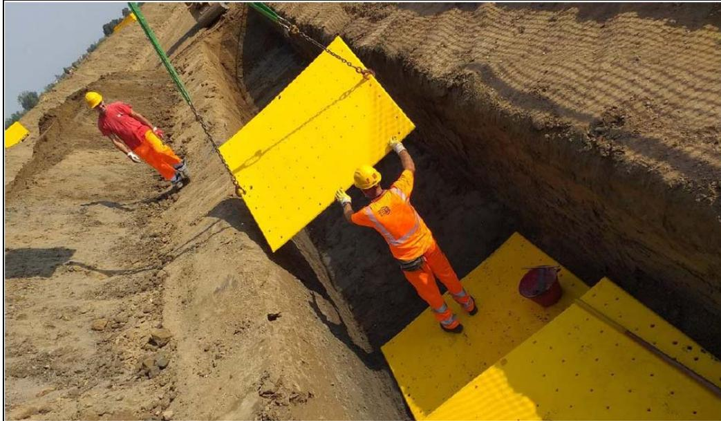
**Foto 3.1.8/B Rinterro della condotta e posa piastra di protezione HDPE**
