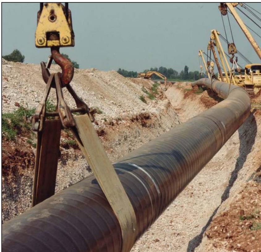
**Foto 3.1.7/A** Posa della condotta (esempio di condotta con diametro superiore alla linea in progetto)
