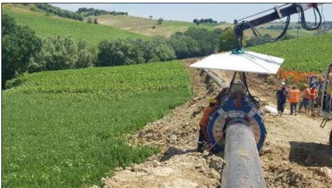
**Foto 3.1.4/B**      **Esempio di saldatura automatica**
