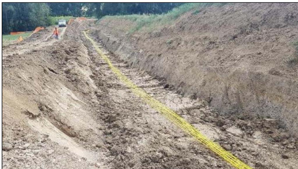
**Foto 3.1.8/A Rinterro della condotta e posa del nastro di avvertimento**
