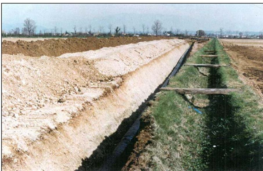
**Foto 3.1.7/B** Tratto di condotta posata, si nota l'accantonamento dello strato humico separato dal materiale di scavo della trincea
