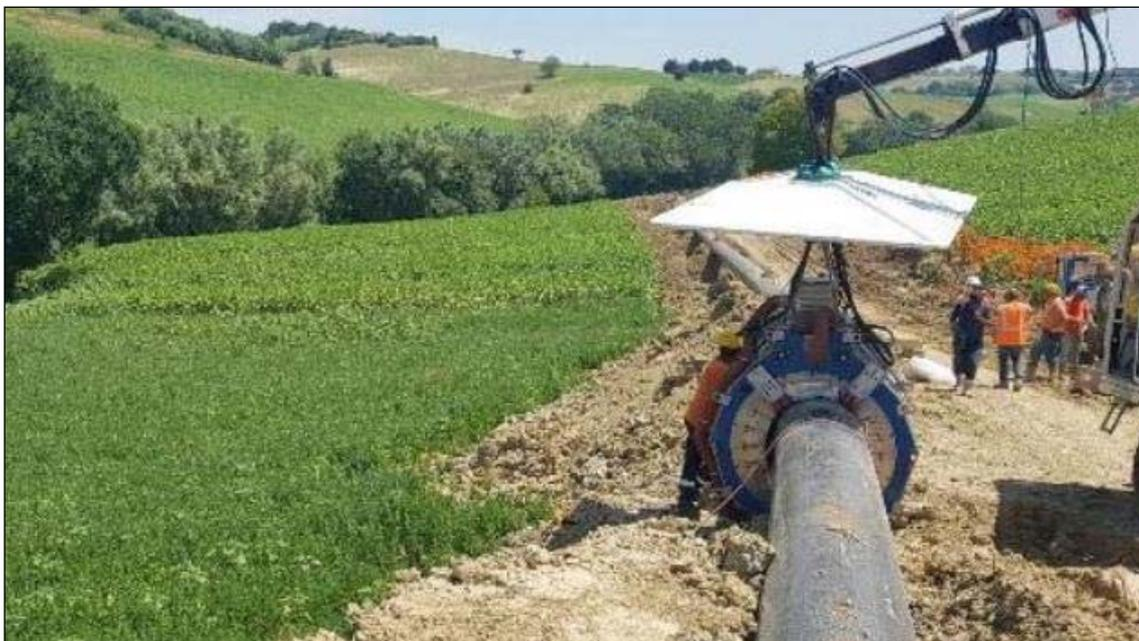
**Foto 3.1/E Esempio di saldatura automatica**
