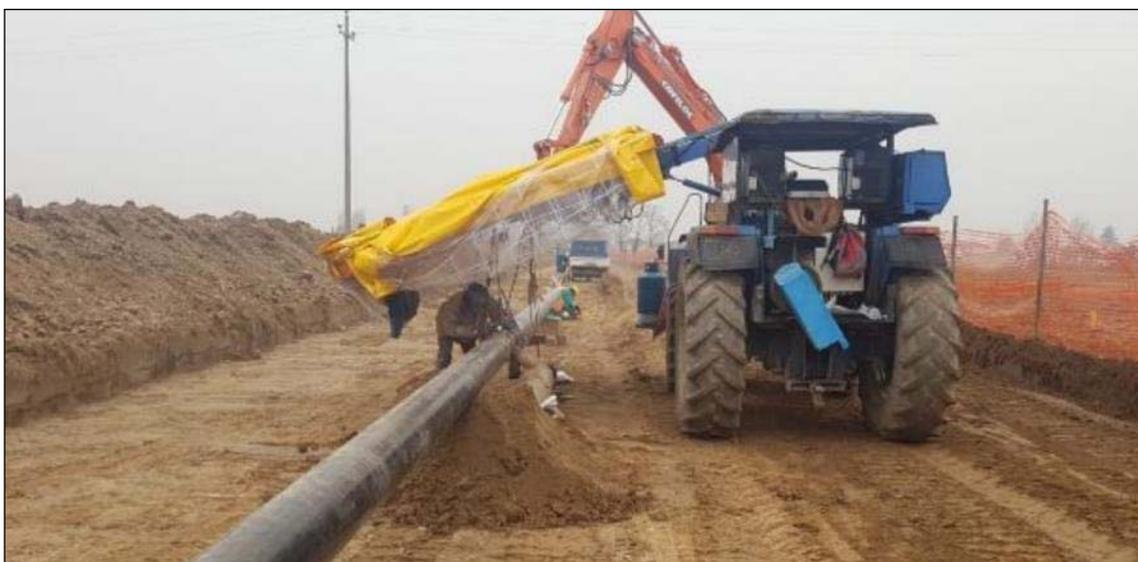
**Foto 3.1/D Esempio di saldatura manuale**
