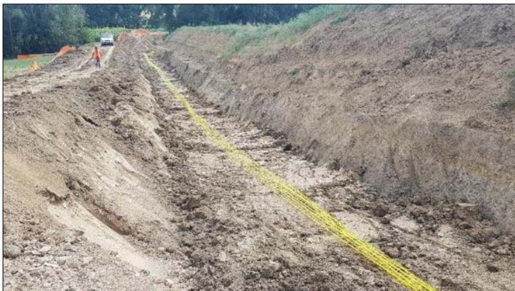
**Foto 3.1/I Rinterro della condotta e posa del nastro di avvertimento**
