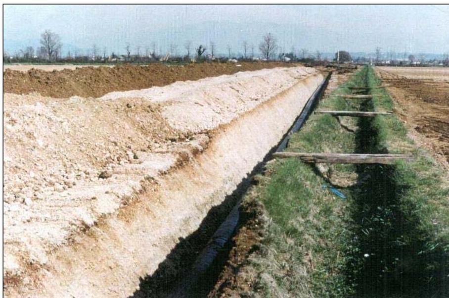
**Foto 3.1/H** Tratto di condotta posata, si nota l'accantonamento dello strato humico separato dal materiale di scavo della trincea
