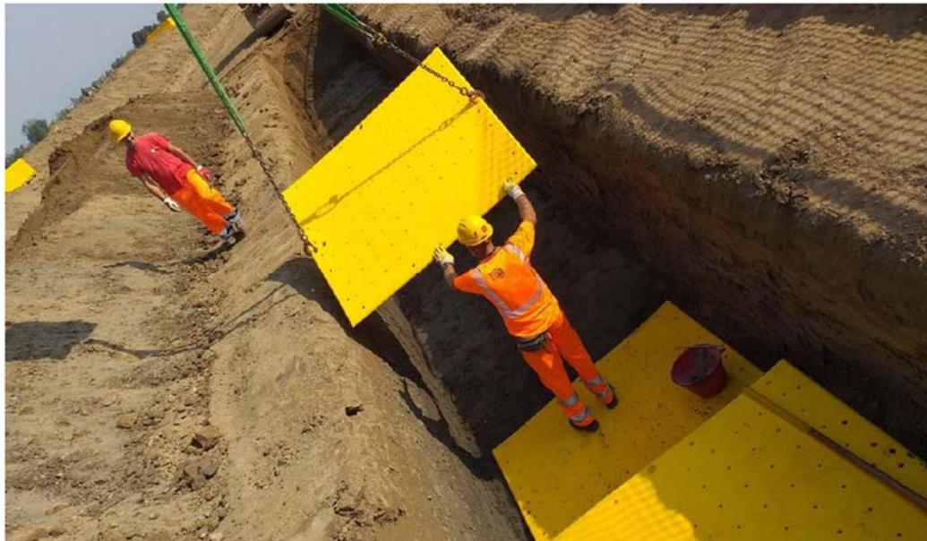
**Foto 3.1/J Rinterro della condotta e posa piastra di protezione HDPE**
