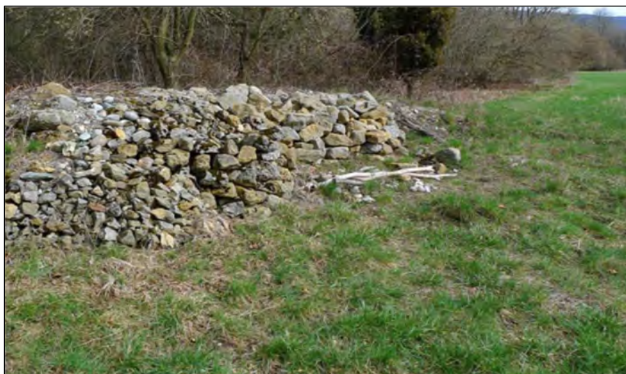
Figura 48. Esempio di cumulo di pietre costruito in una zona di transizione tra un'area prativa e una lingua boscata. Si noti l'eterogeneità, le forme irregolari, le dimensioni delle pietre e la presenza di una fascia erbosa perimetrale.
