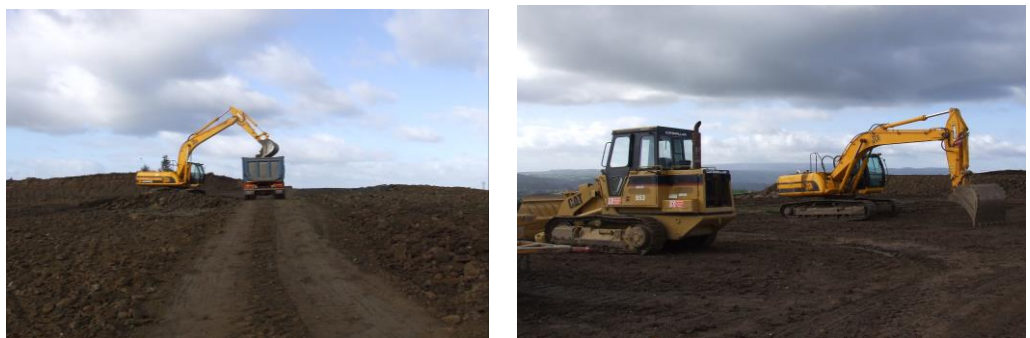
Fig. 28 – Operazioni di realizzazione piazzole
