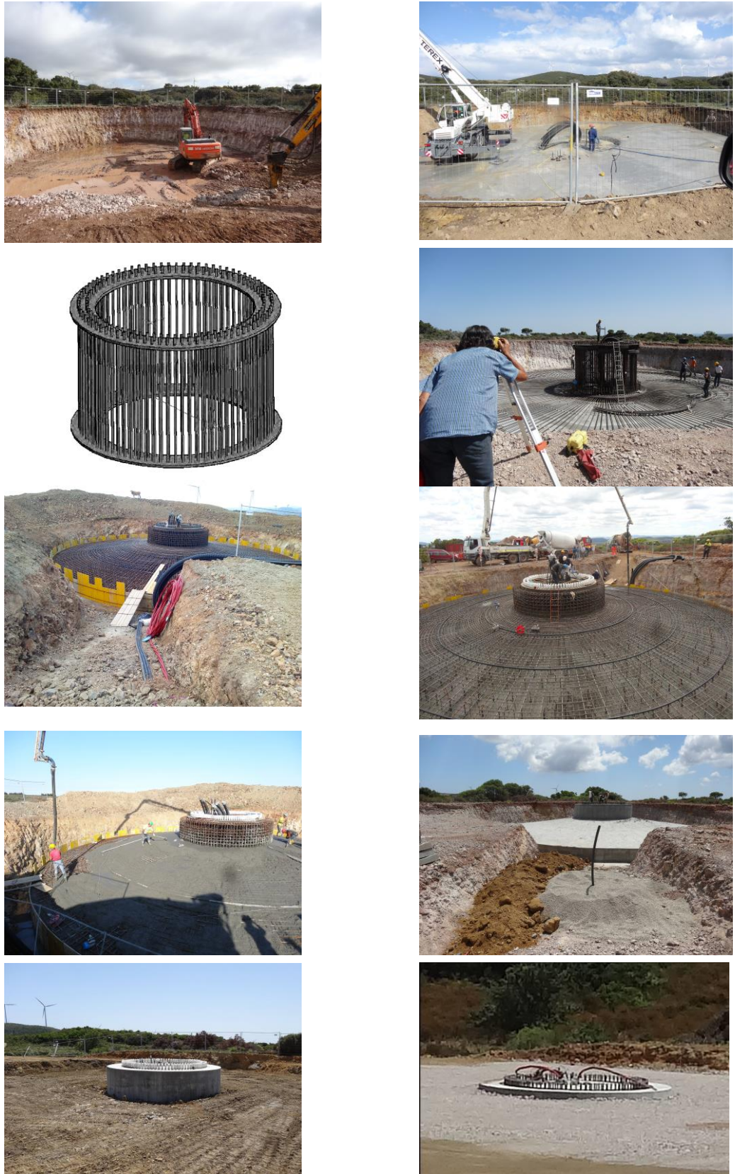
Fig. 25 – Fasi realizzative fondazioni
