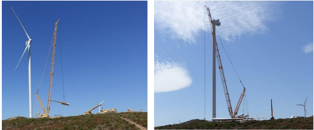
Fig. 31 – Operazioni di montaggio con gru
