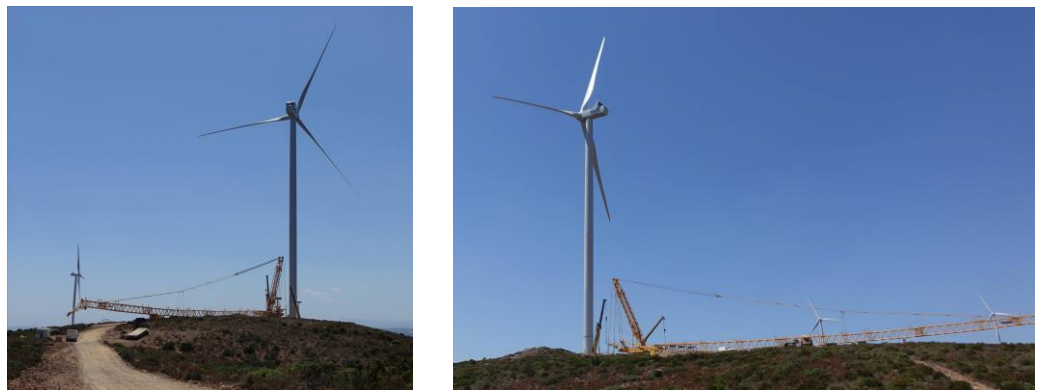
Fig. 28 – Spazi di montaggio per la gru principale
