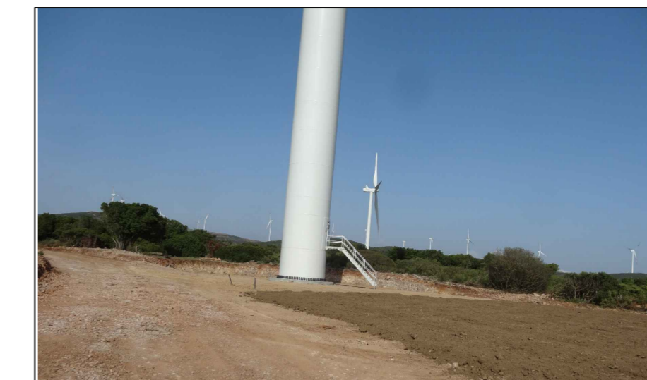
Completamento fase realizzativa impianto con estensione terra vegetale. (settembre 2019)
