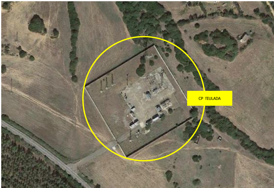
Figura 2 – Vista aerea Cabina Primaria Teulada (tratta da Google Earth)
