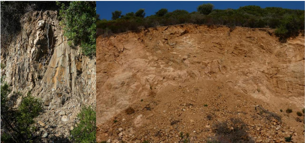
Figura 19 A sinistra Scivolamento di un cuneo su taglio stradale, a destra scarpata dissestata su probabile vecchia cava.
