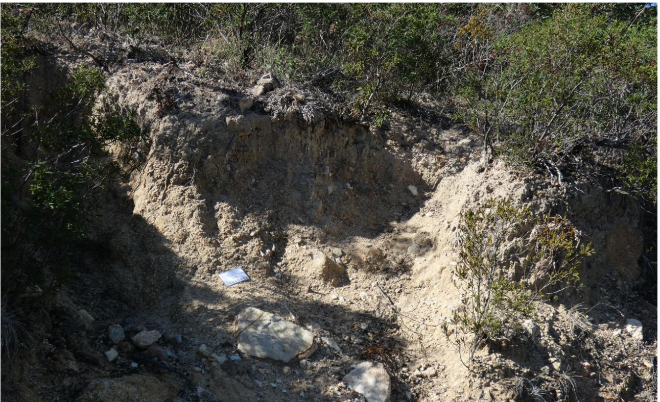
Figura 22 Morfologie erosive in corrispondenza dei tagli stradali
