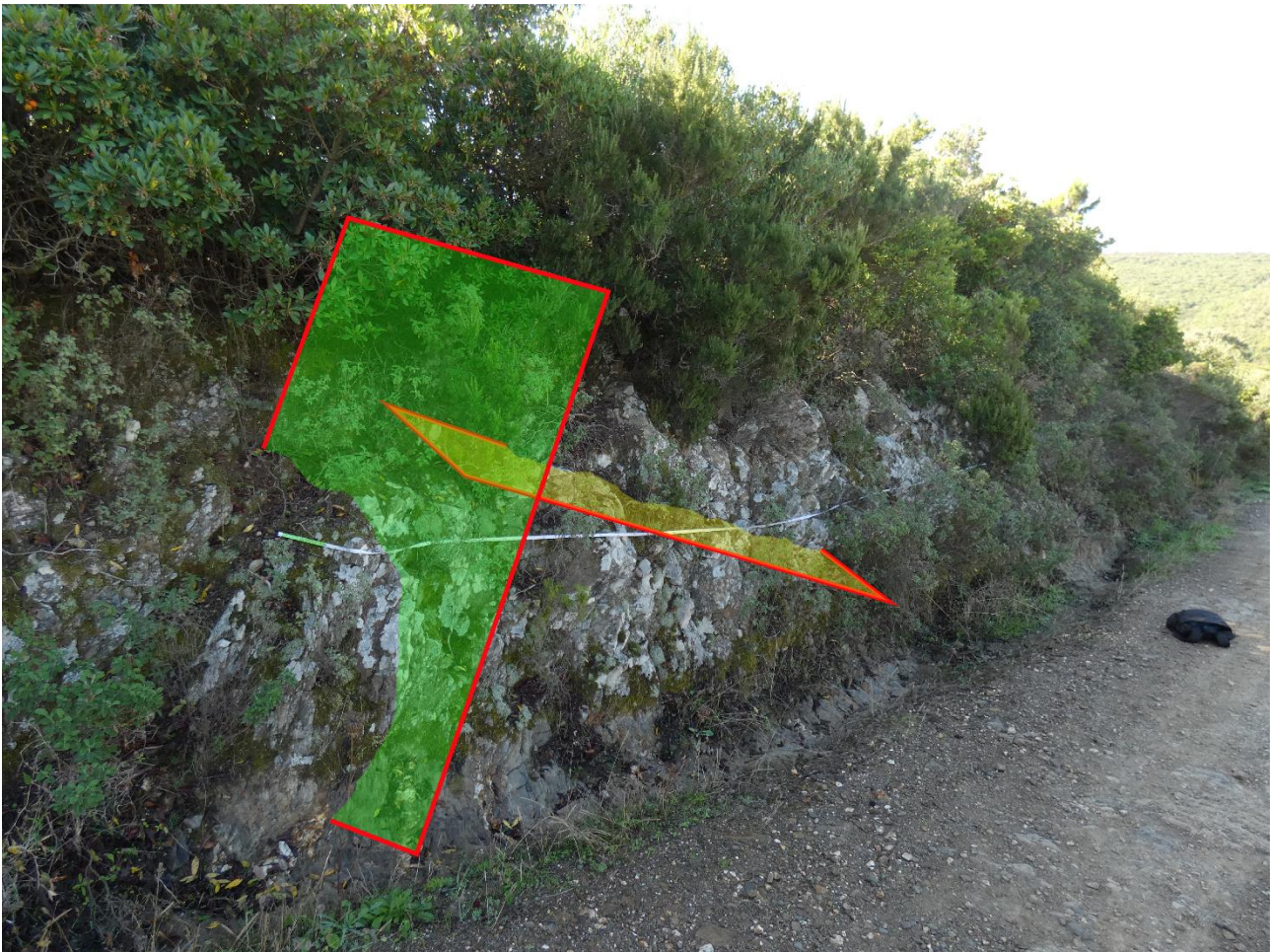
Figura 20 Vista sull'affioramento della Fm. Nebida con tracce dei giunti di fratturazione
