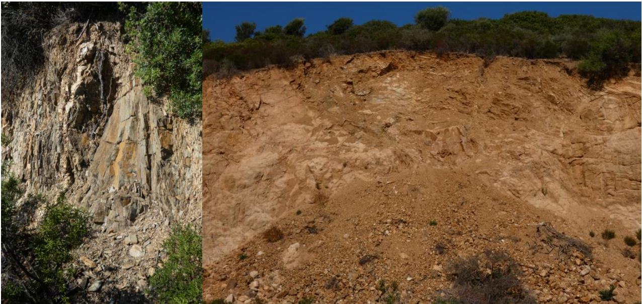
Figura 27 A sinistra Scivolamento di un cuneo su taglio stradale, a destra scarpata dissestata su probabile vecchia cava.
