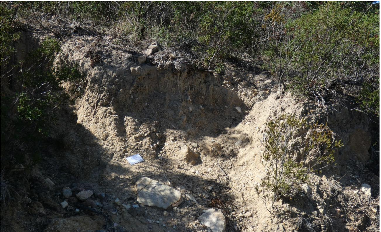
Figura 31 Morfologie erosive in corrispondenza dei tagli stradali
