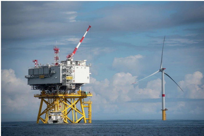
Figura 3:15: Tipica installazione di OSS con fondazione fissa [Fonte* Saint Nazaire OWF - EDF]
