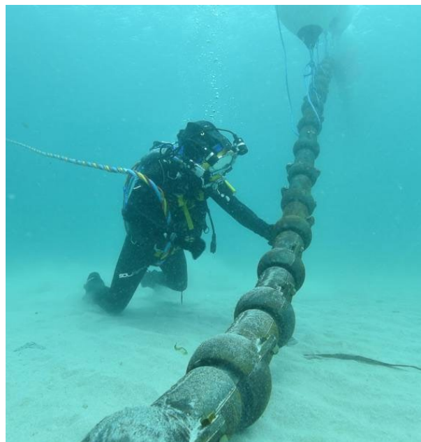
Figura 3:12: Esempio di metodo di posa con gusci di protezione (Fonte: Farinia Group)
