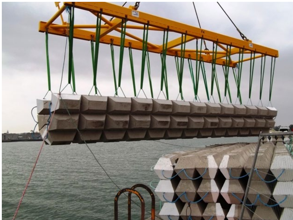
Figura 3:10: Protezione di un cavo sottomarino con cubicoli (Fonte: Subsea Protection Systems Ltd)
