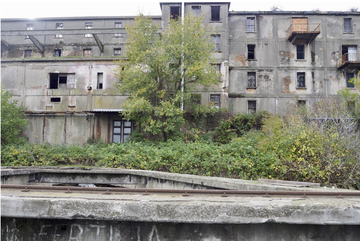
Figura 8: Complesso Ex Monopolio Sali e Tabacchi – vista ravvicinata fronte S – congiunzione tra fabbricato Sali (sx) e Fabbricato Tabacchi (a dx)
