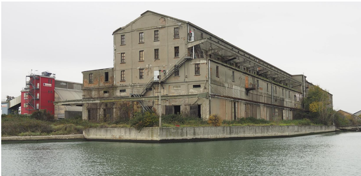
Figura 5: Complesso Ex Monopolio Sali e Tabacchi – vista da E
