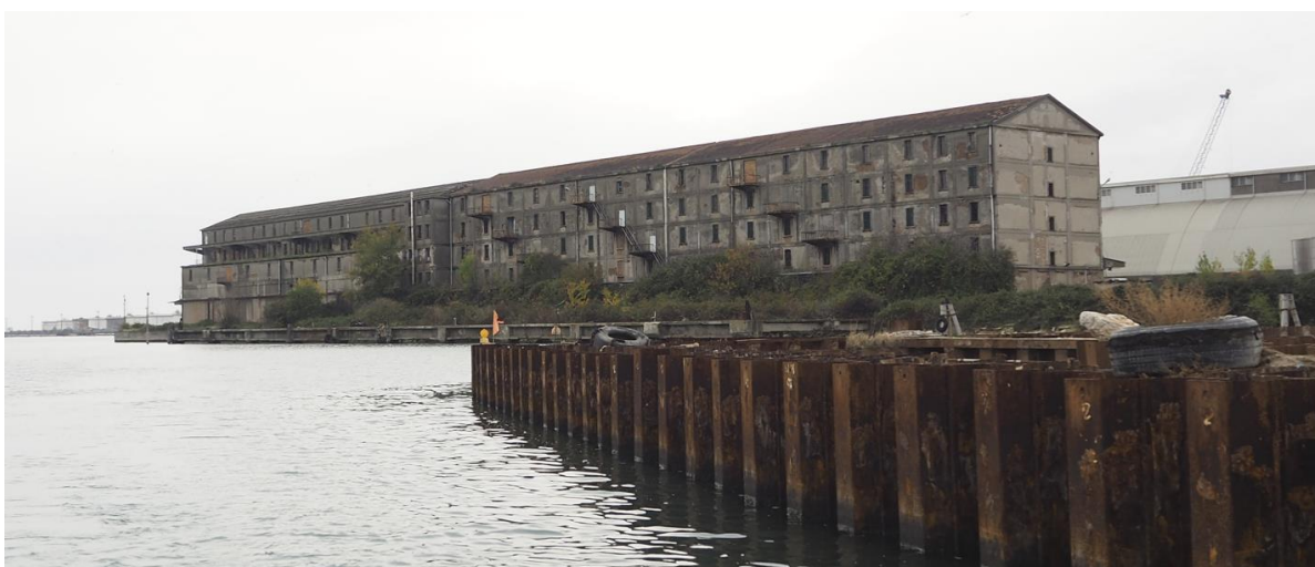
Figura 6: Complesso Ex Monopolio Sali e Tabacchi – vista da NO
