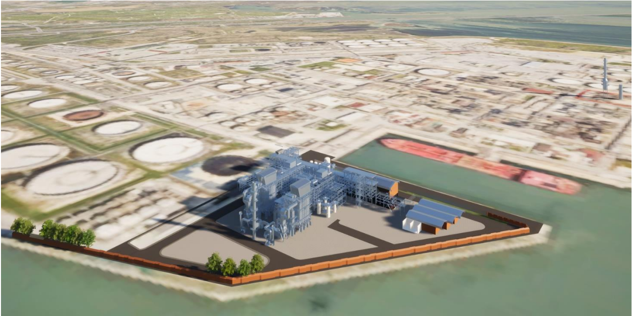
Figura 21: Vista a volo d'uccello da S; si notano due piccoli filari alberati in prossimità dell'ingresso dell'impianto (sx nell'immagine) e presso uno dei vertici del perimetro della recinzione.
