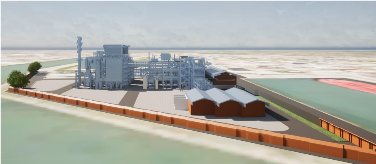
Figura 17: Vista d'insieme da SE: in primo piano la recinzione con elementi modulari sfalsati e l'Edificio elettrico
