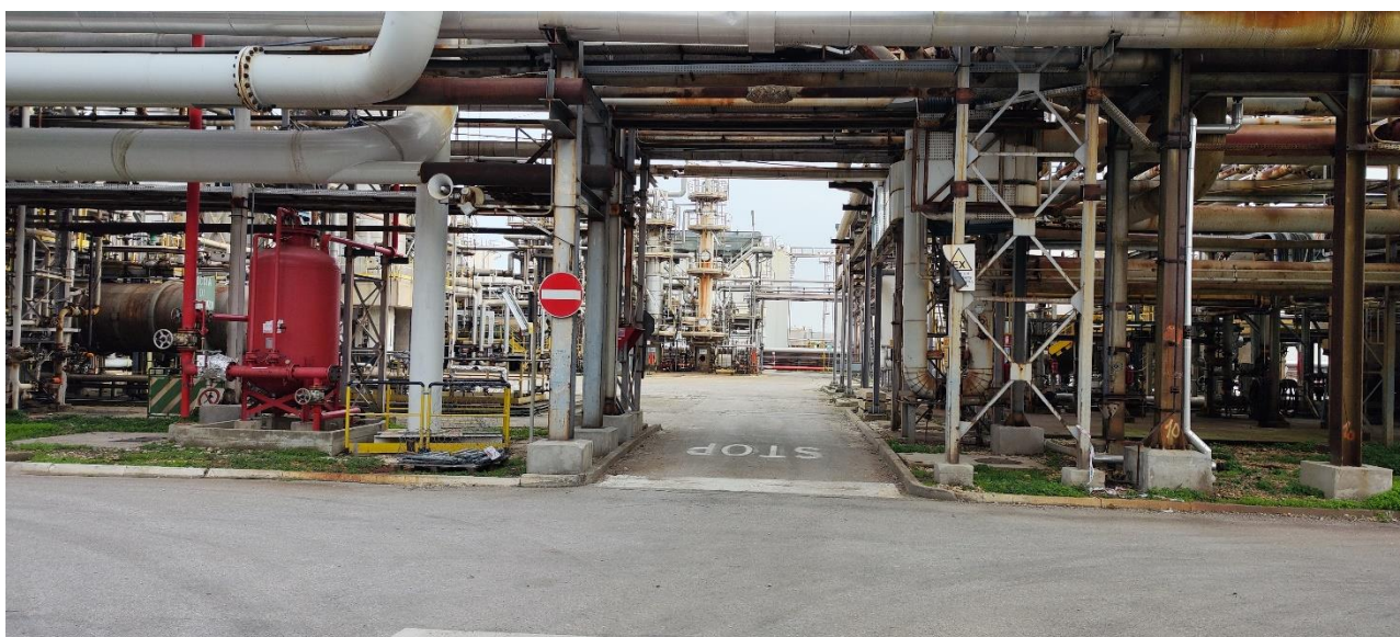
Figura 2-25 Sopralluogo area Ecofining – n.8 mappa foto
