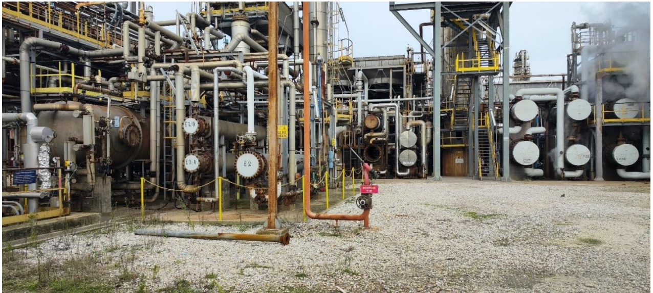
Figura 2-26 Sopralluogo area Ecofining – n.9 mappa foto
