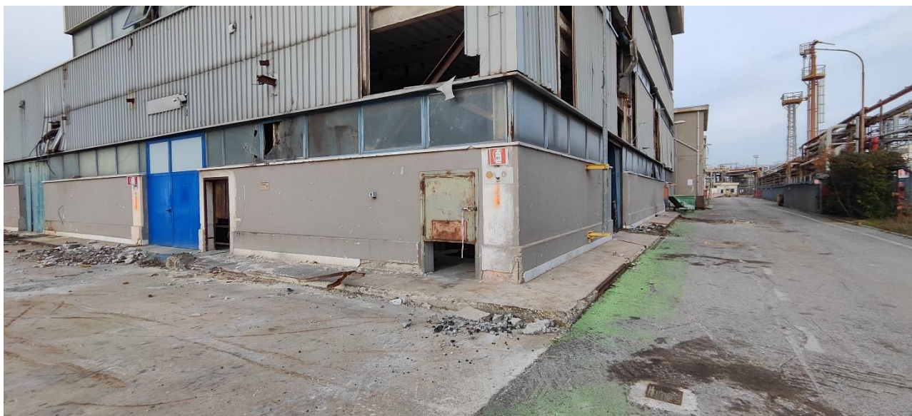
Figura 2-20 Sopralluogo area Steam Reforming – n.4 mappa foto
