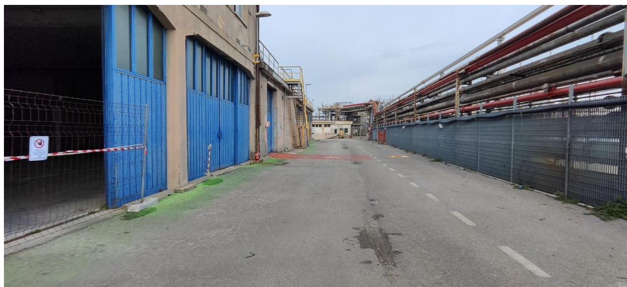
Figura 2-19 Sopralluogo area Steam Reforming – n.3 mappa foto
