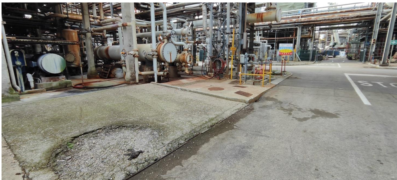
Figura 2-28 Sopralluogo area Ecofining – n.11 mappa foto
