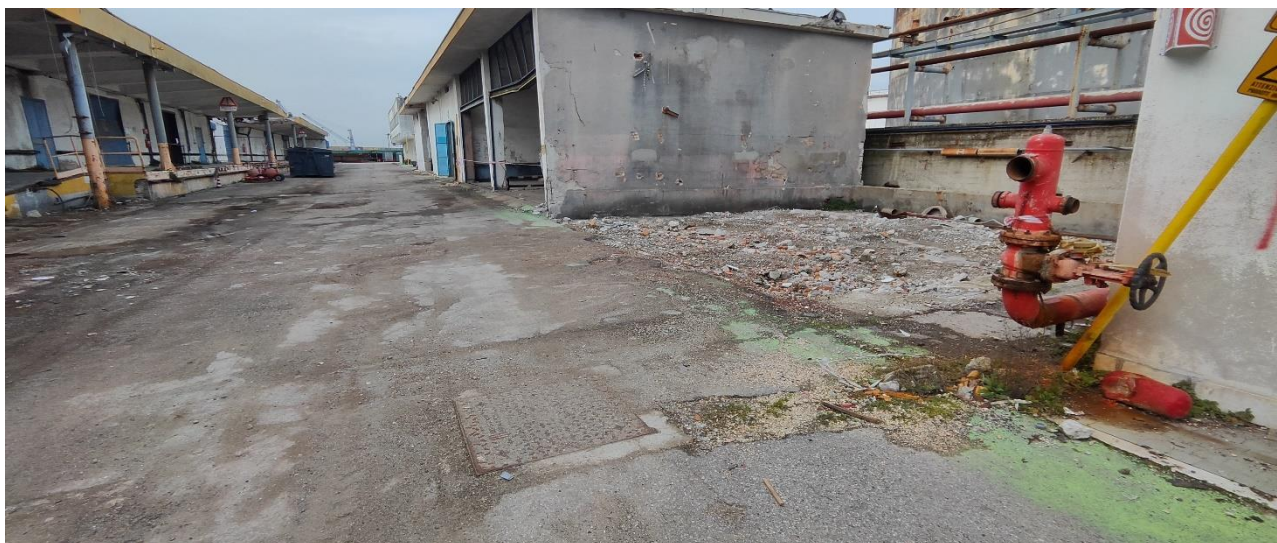
Figura 2-18 Sopralluogo area Steam Reforming – n.2 mappa foto
