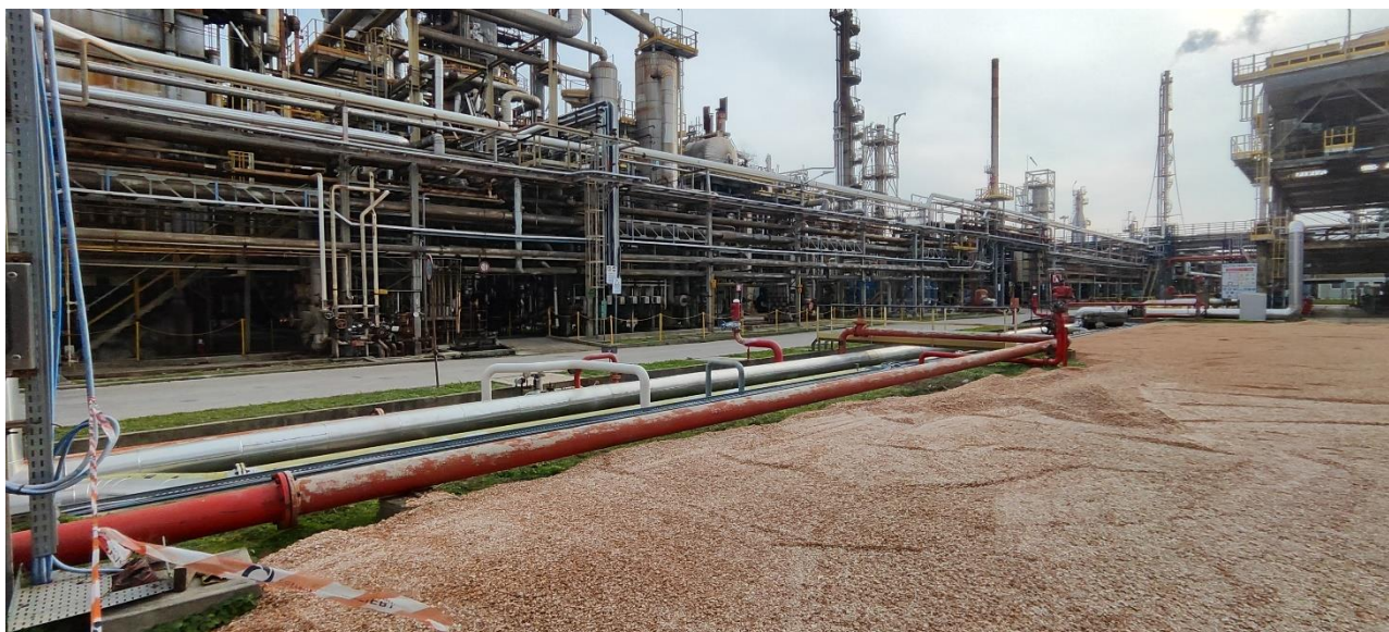
Figura 2-29 Sopralluogo area Ecofining – n.12 mappa foto
