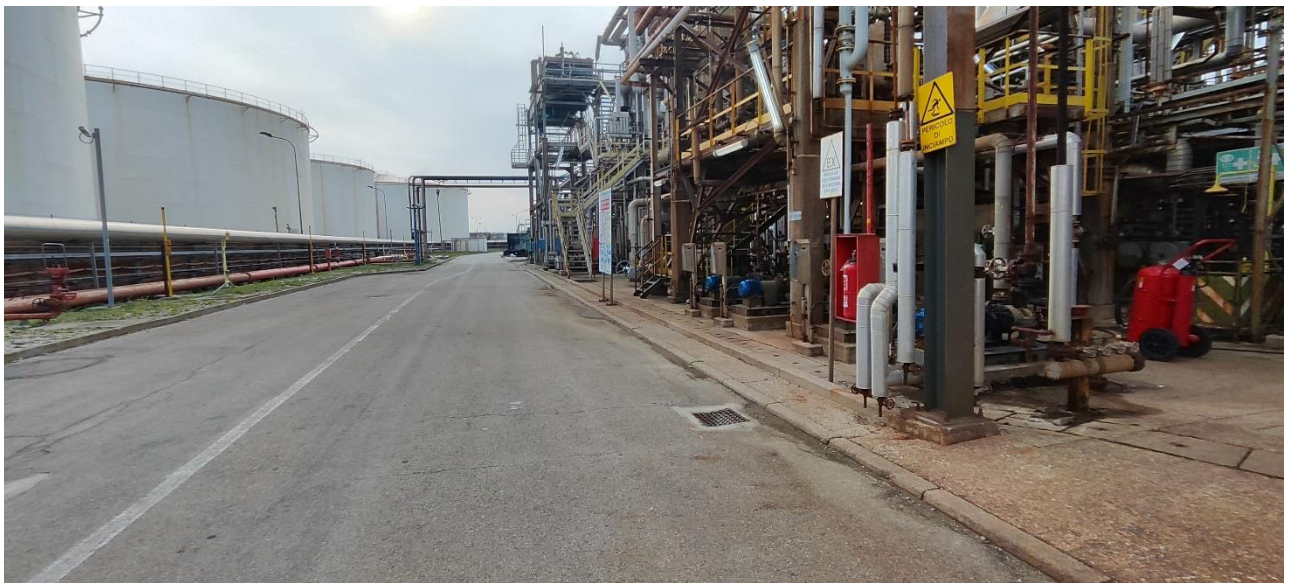
Figura 2-27 Sopralluogo area Ecofining – n.10 mappa foto
