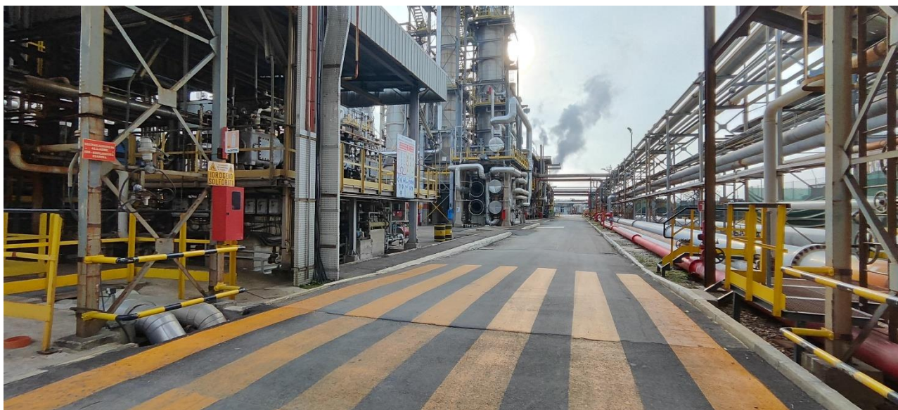
Figura 2-24 Sopralluogo area Ecofining – n.7 mappa foto
