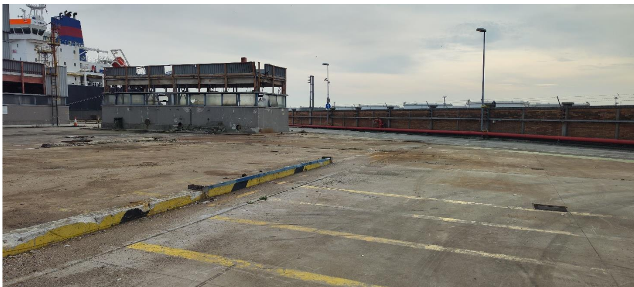
Figura 2-22 Sopralluogo area Steam Reforming – n.6 mappa foto
