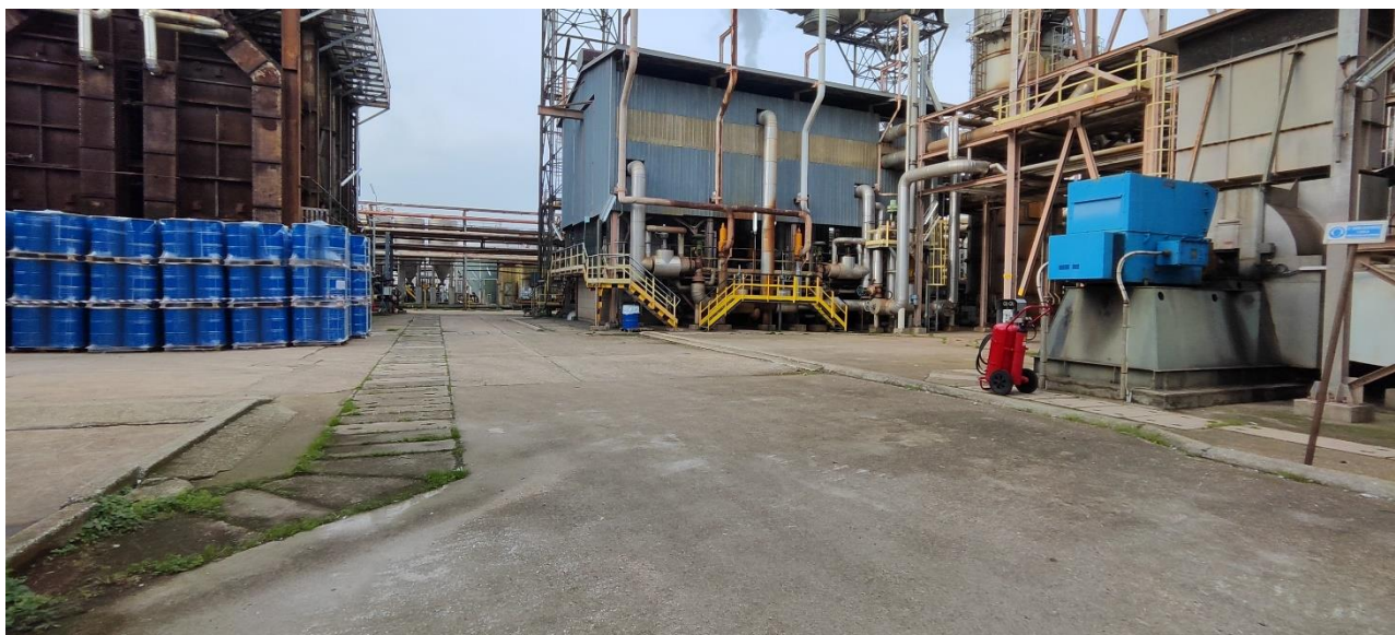
Figura 2-30 Sopralluogo area Ecofining – n.13 mappa foto
