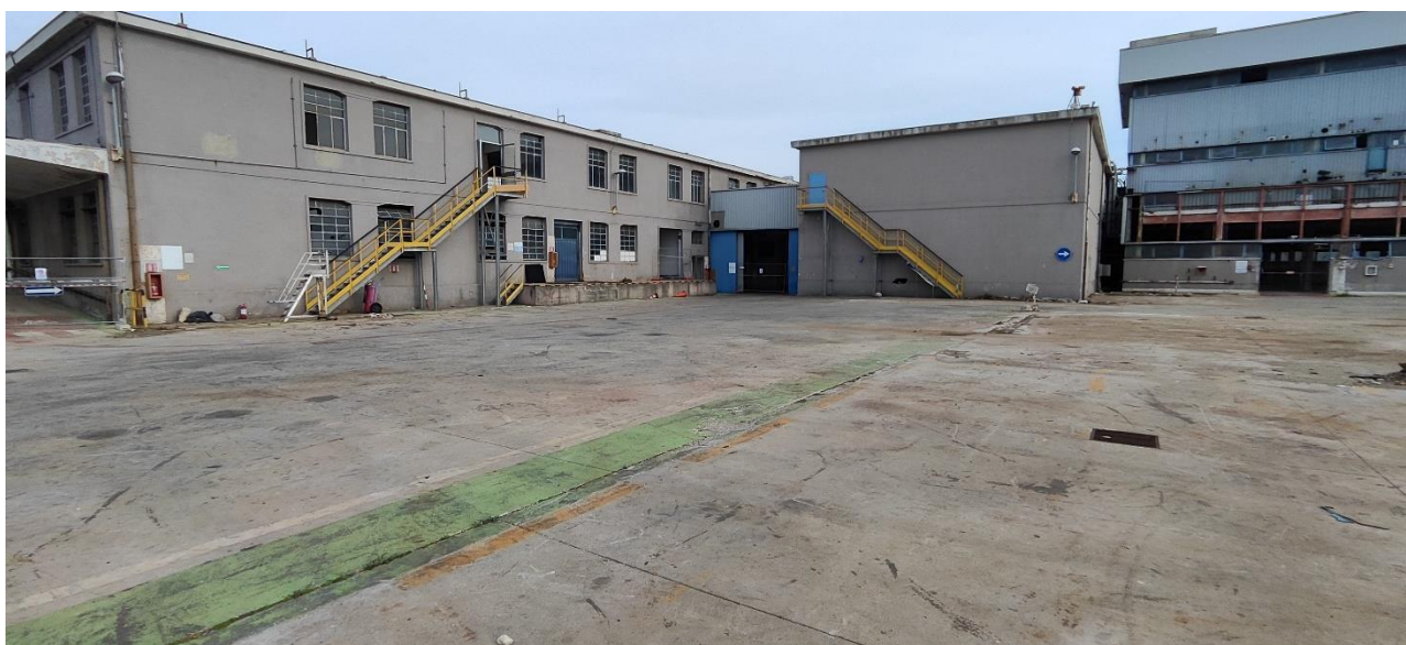
Figura 2-21 Sopralluogo area Steam Reforming – n.5 mappa foto
