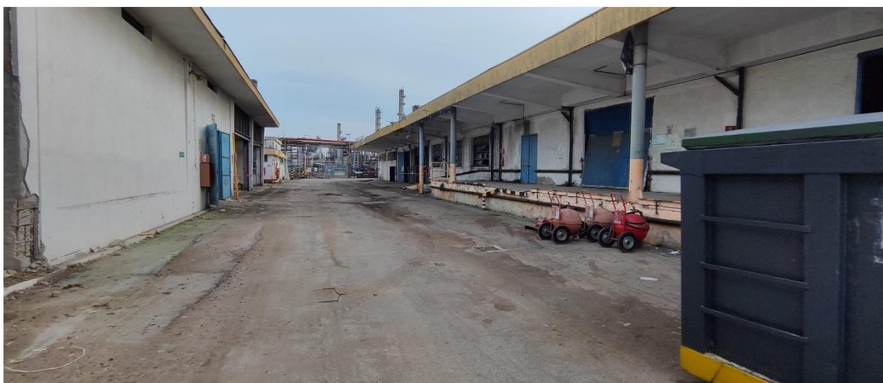
Figura 2-17 Sopralluogo area Steam Reforming – n.1 mappa foto
