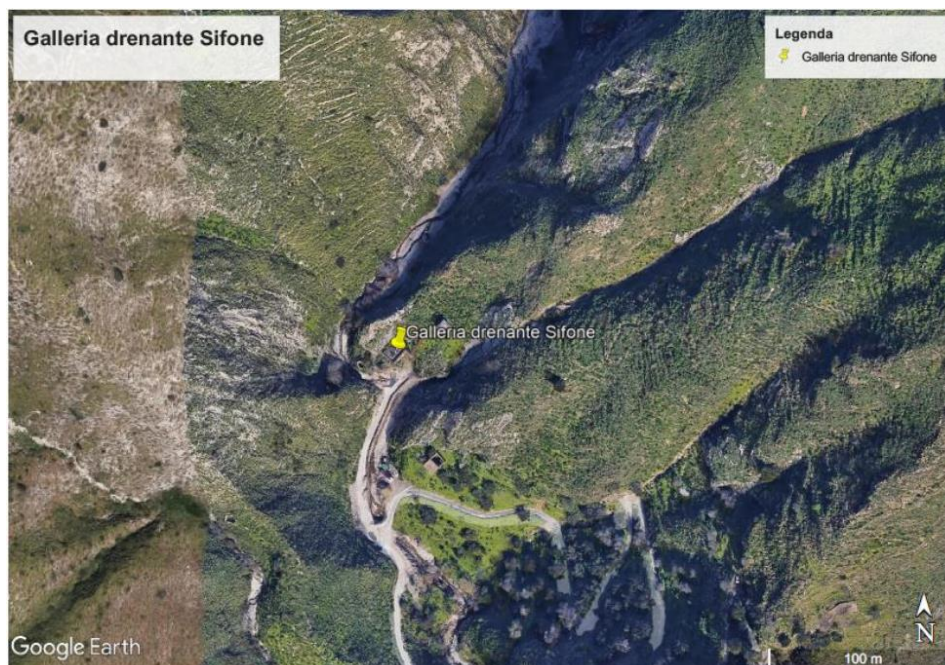
Figura 22. Ubicazione dell'imbocco della Galleria drenante Sifone.
