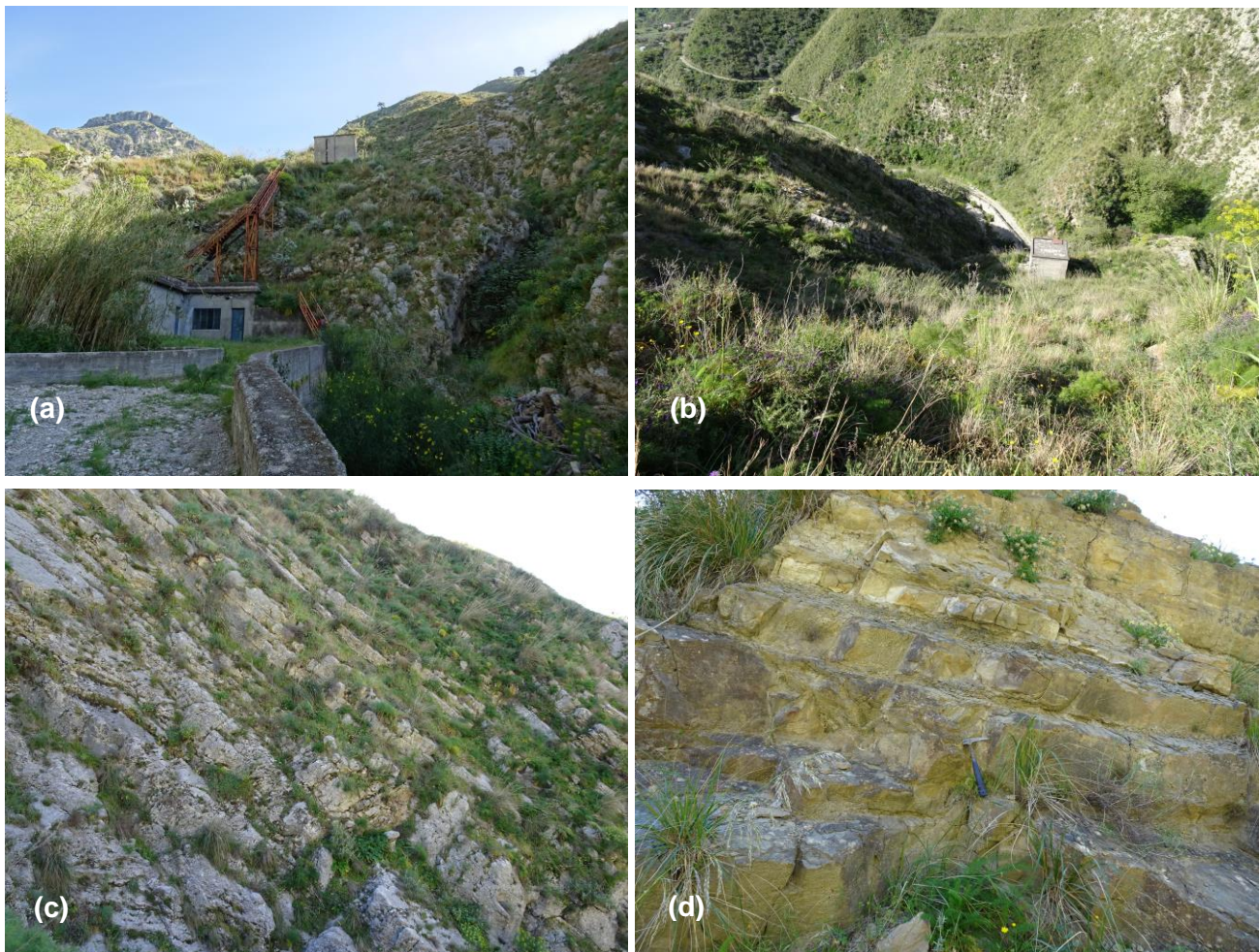
Figura 23. Immagini del settore della galleria drenante Sifone: (a) vista frontale del bottino di presa della galleria Sifone, (b) vista dall'alto del bottino di presa, (c) stratificazione dei calcari DOA costituenti l'acquifero, (d) calcari marnosi MED costituenti l'aquiclude che circonda l'acquifero potabile.
