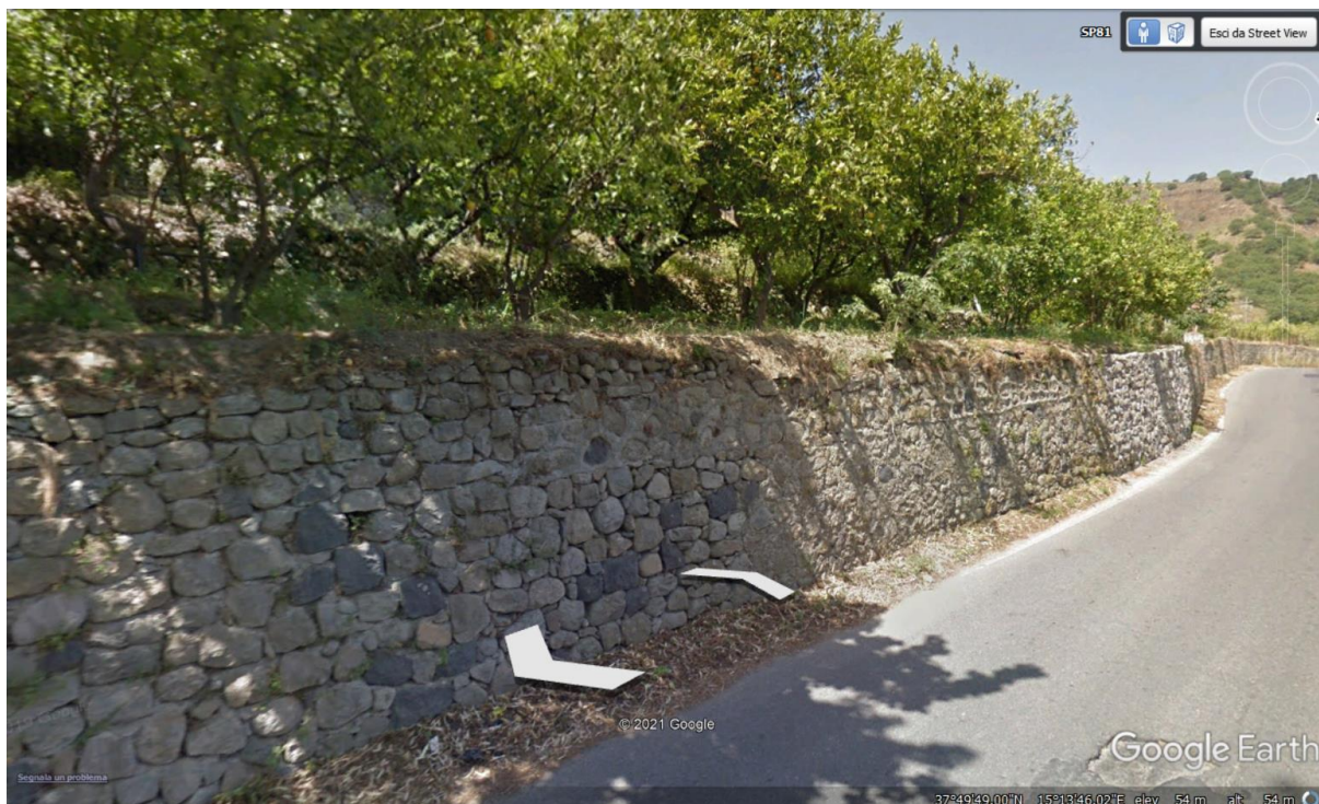
Figura 23 - Fotografia scattata in corrispondenza del segnaposto VI02-6.
