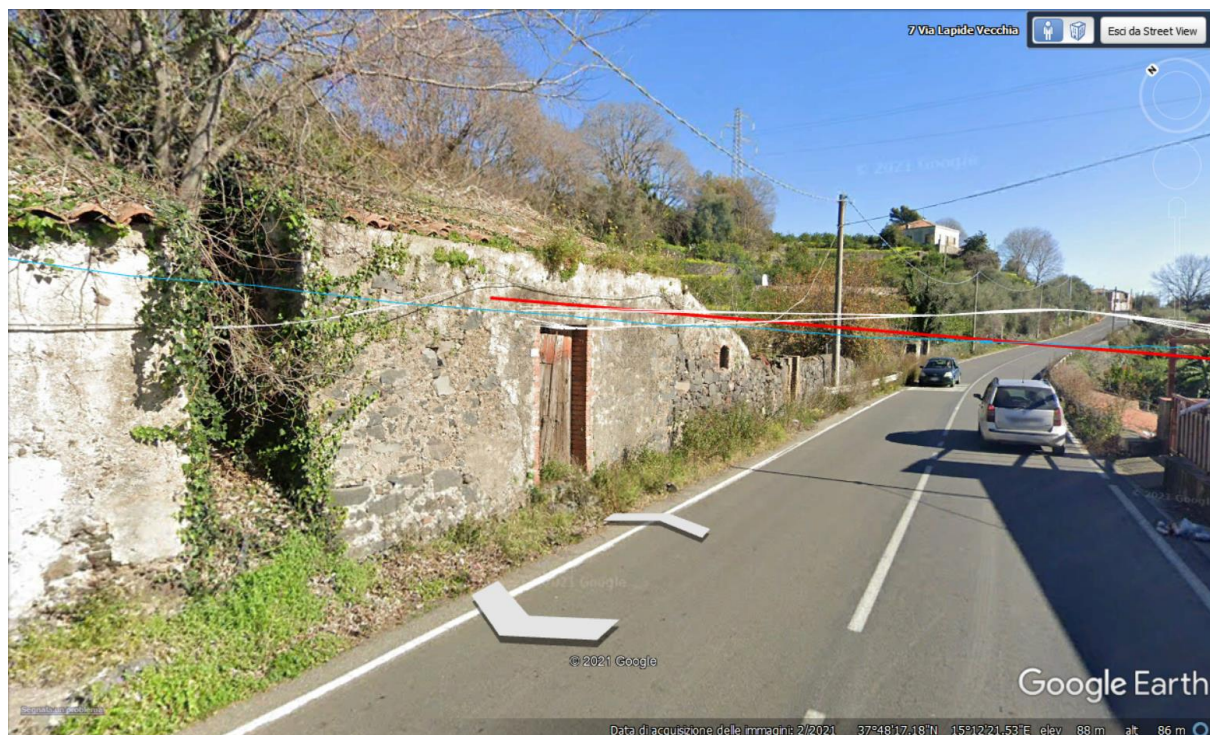
Figura 6 - Fotografia scattata in corrispondenza del segnaposto VI01-3.
