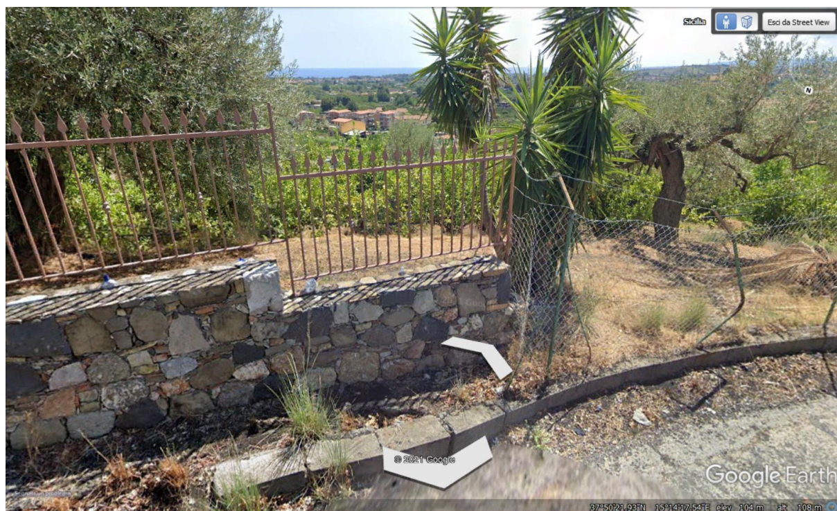
Figura 18 - Fotografia scattata in corrispondenza del segnaposto VI02-2.
