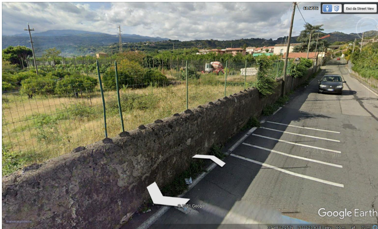
Figura 3 - Fotografia scattata in corrispondenza del segnaposto VI01-1.
