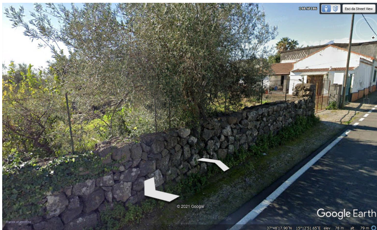
Figura 8 - Fotografia scattata in corrispondenza del segnaposto VI01-4.
