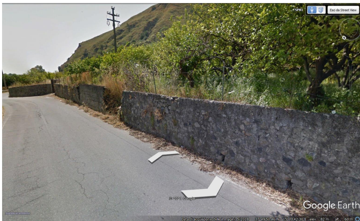
Figura 22 - Fotografia scattata in corrispondenza del segnaposto VI02-5.
