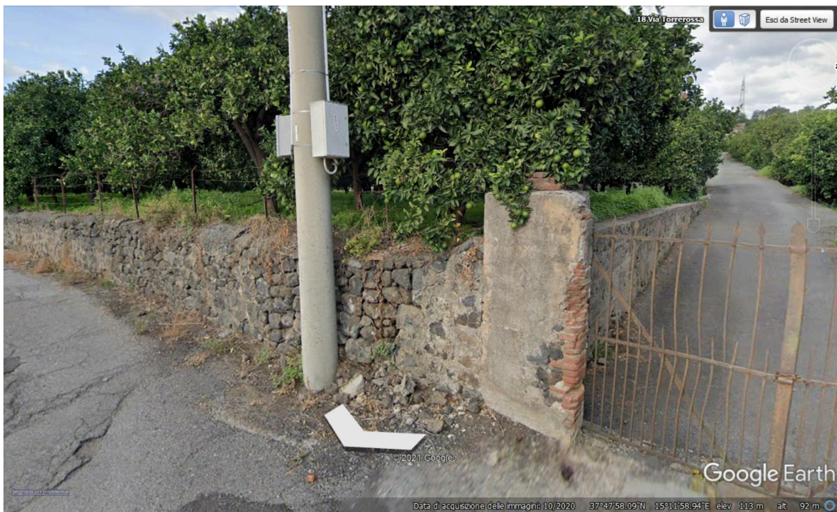
Figura 5 - Fotografia scattata in corrispondenza del segnaposto VI01-2.
