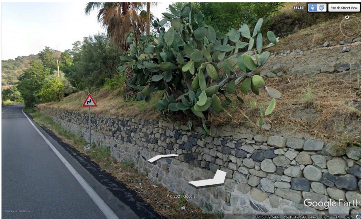
Figura 19 - Fotografia scattata in corrispondenza del segnaposto VI02-3.
