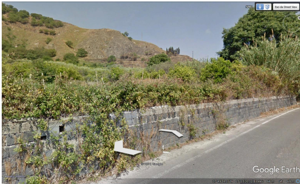
Figura 21 - Fotografia scattata in corrispondenza del segnaposto VI02-4.
