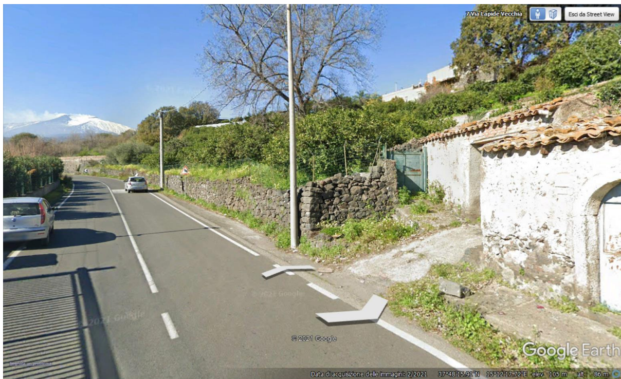
Figura 7 - Fotografia scattata in corrispondenza del segnaposto VI01-3.
