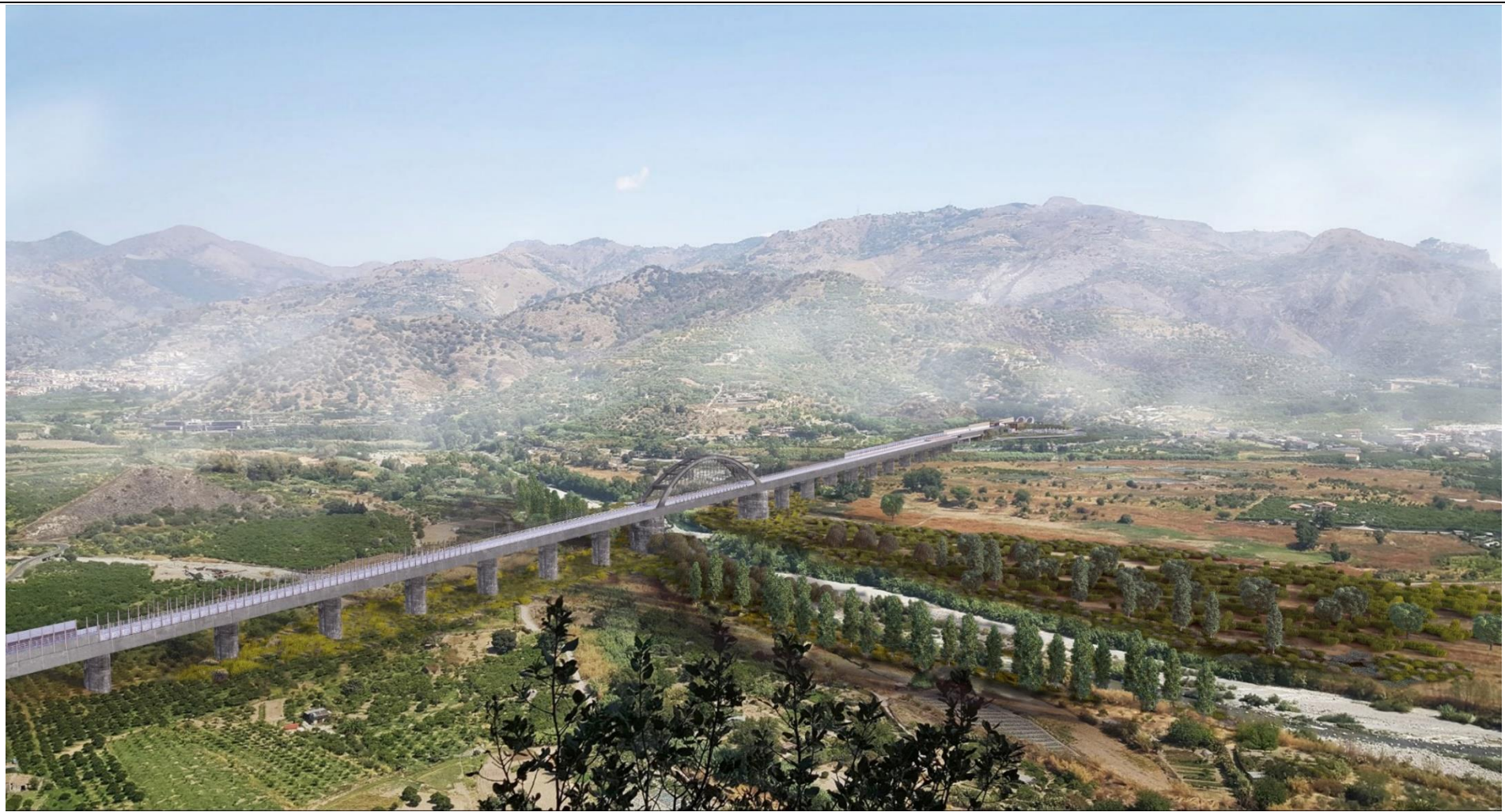
1.1 VISTA 1 – VIADOTTO ALCANTARA
