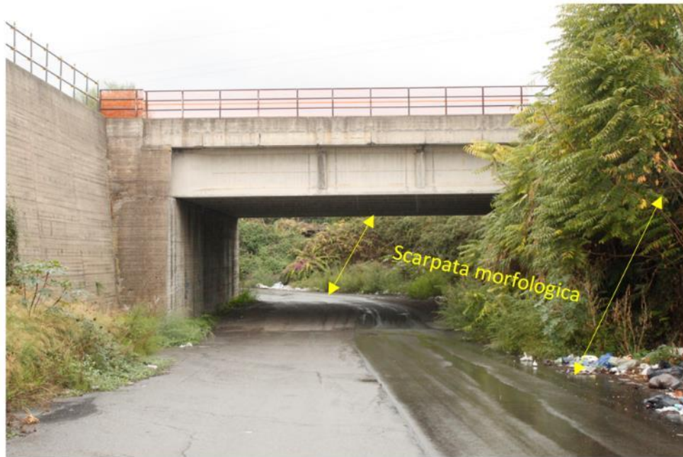
Figura 5 – Scarpata di faglia in corrispondenza dell'intersezione con il nuovo tracciato ferroviario (punto A in Figura 4).
