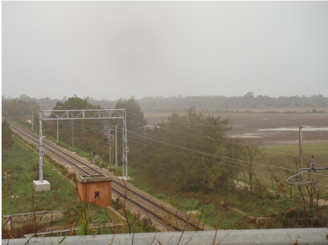
Figura 93 - Area lungo la SP42b che va verso la foce del Fiume Fortore, vista verso mare (PF3).
