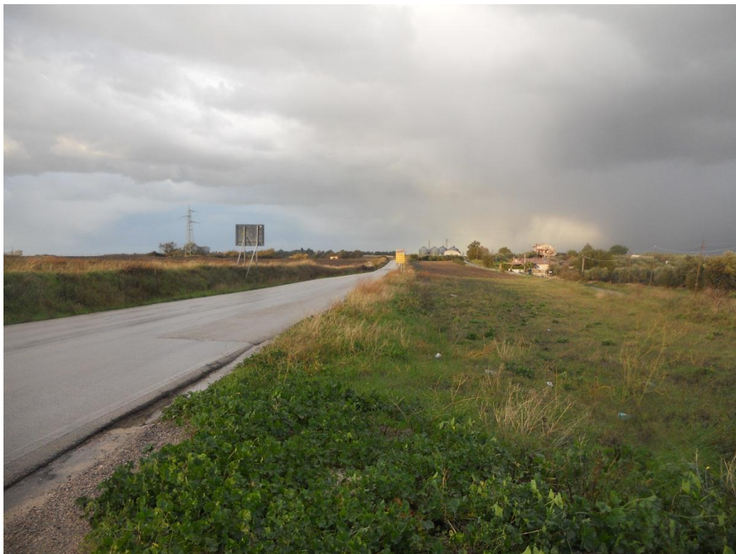
Figura 124 - SP 44 Tra Serracapriola e Chieuti, vista verso mare.
