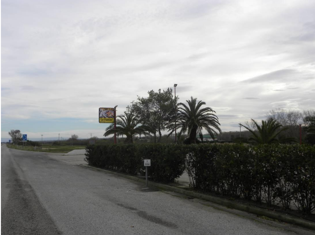
Figura 98 - Tratta lungo la SS 483 tra Campomarino Lido e Chieuti, vista verso monte.
