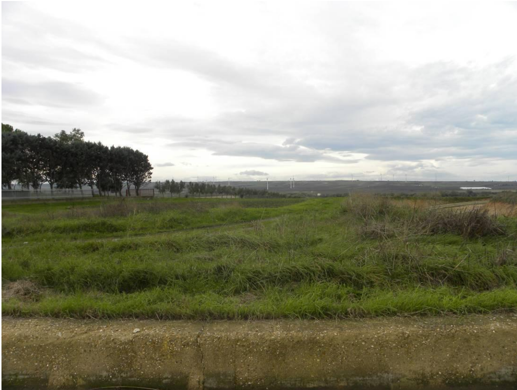
Figura 132 - Tratta lungo la SS 483 Chiети e Ripalta, vista verso monte (PF3).
