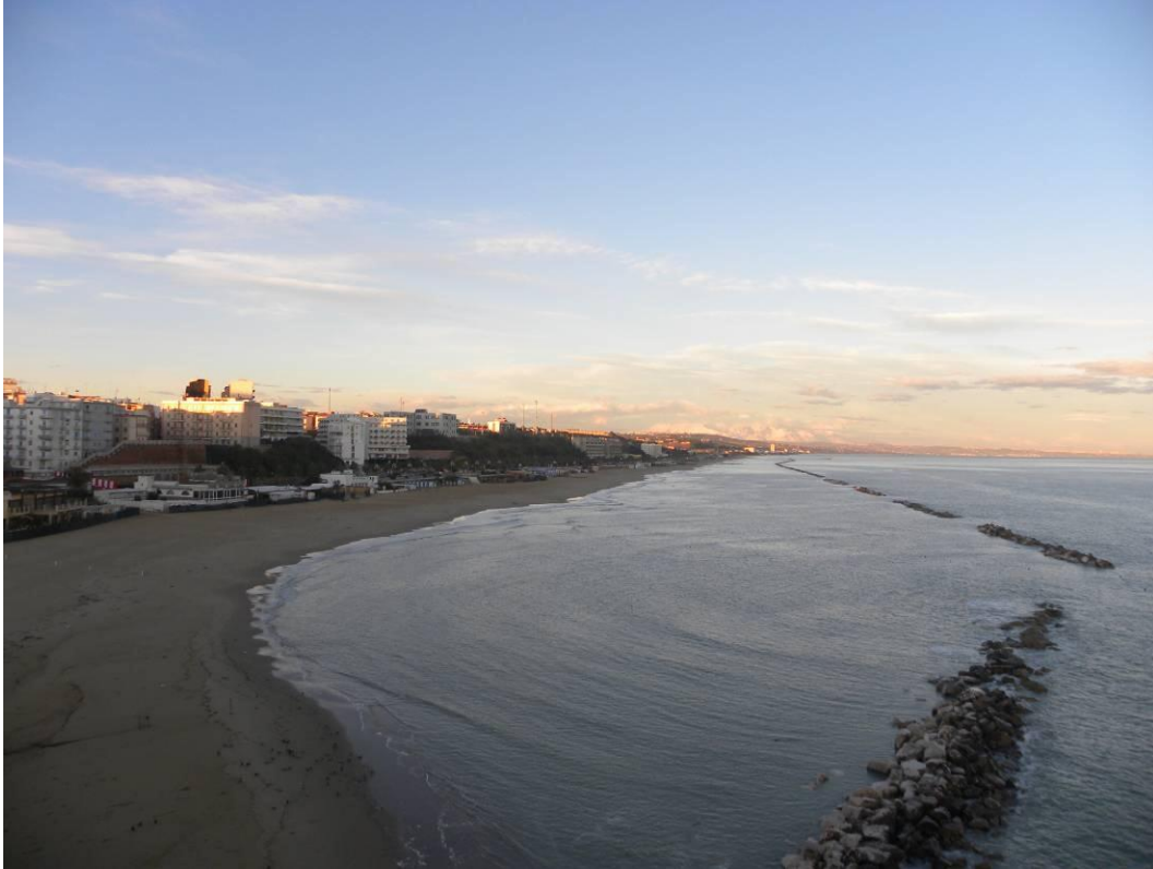
Figura 3 – Litorale di Termoli, area dedicata a stabilimenti balneari e protetta da barriere marine.
