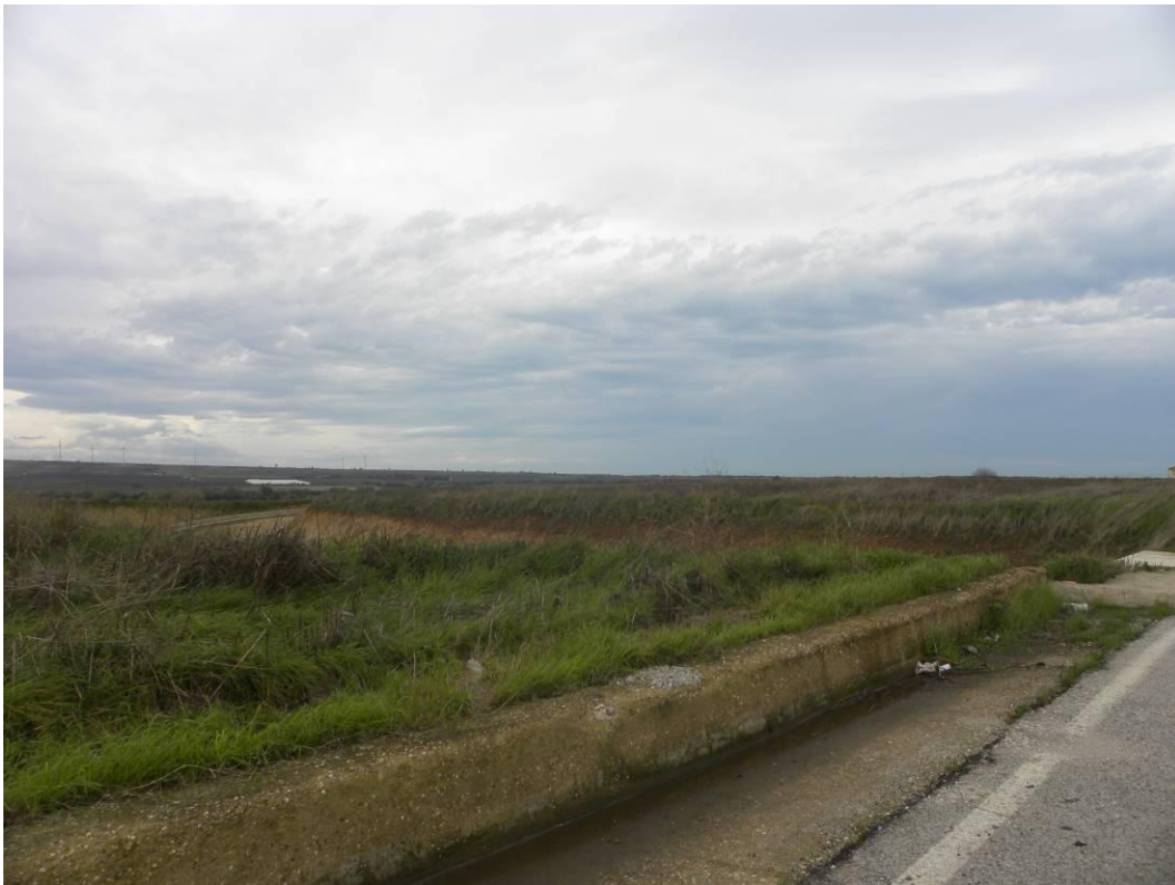
Figura 133 - Tratta lungo la SS 483 Chiети e Ripalta, vista verso monte (PF3).
