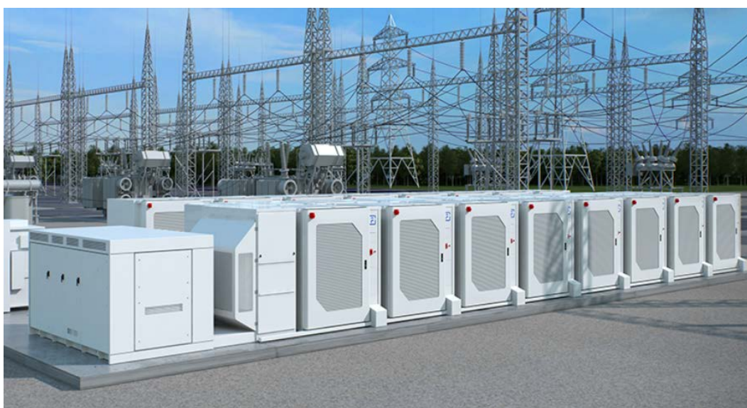
Figura 44: esempio di sistema di stoccaggio per impianto agrivoltaico - Gridstack
