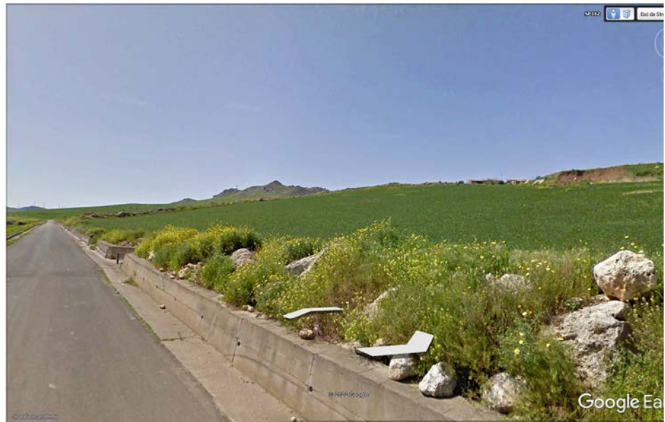
Figura 7: Immagine area di impianto ripresa da SP 179 da nord-est - FONTE: Google Earth
