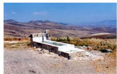
3. Abbeveratoio- Contrada Mansialino
