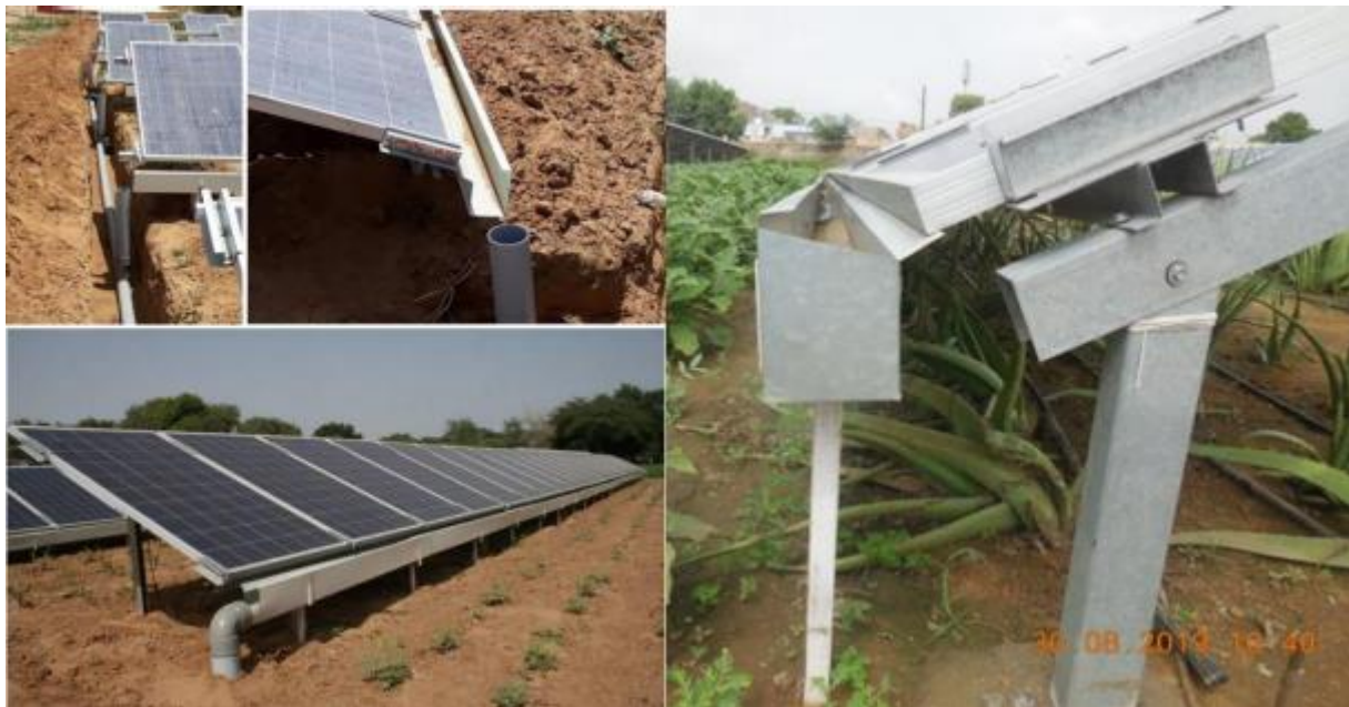
Figura 3-1. Esempio di impianto fotovoltaico a terra con grondaia integrata per la raccolta dell'acqua piovana.
