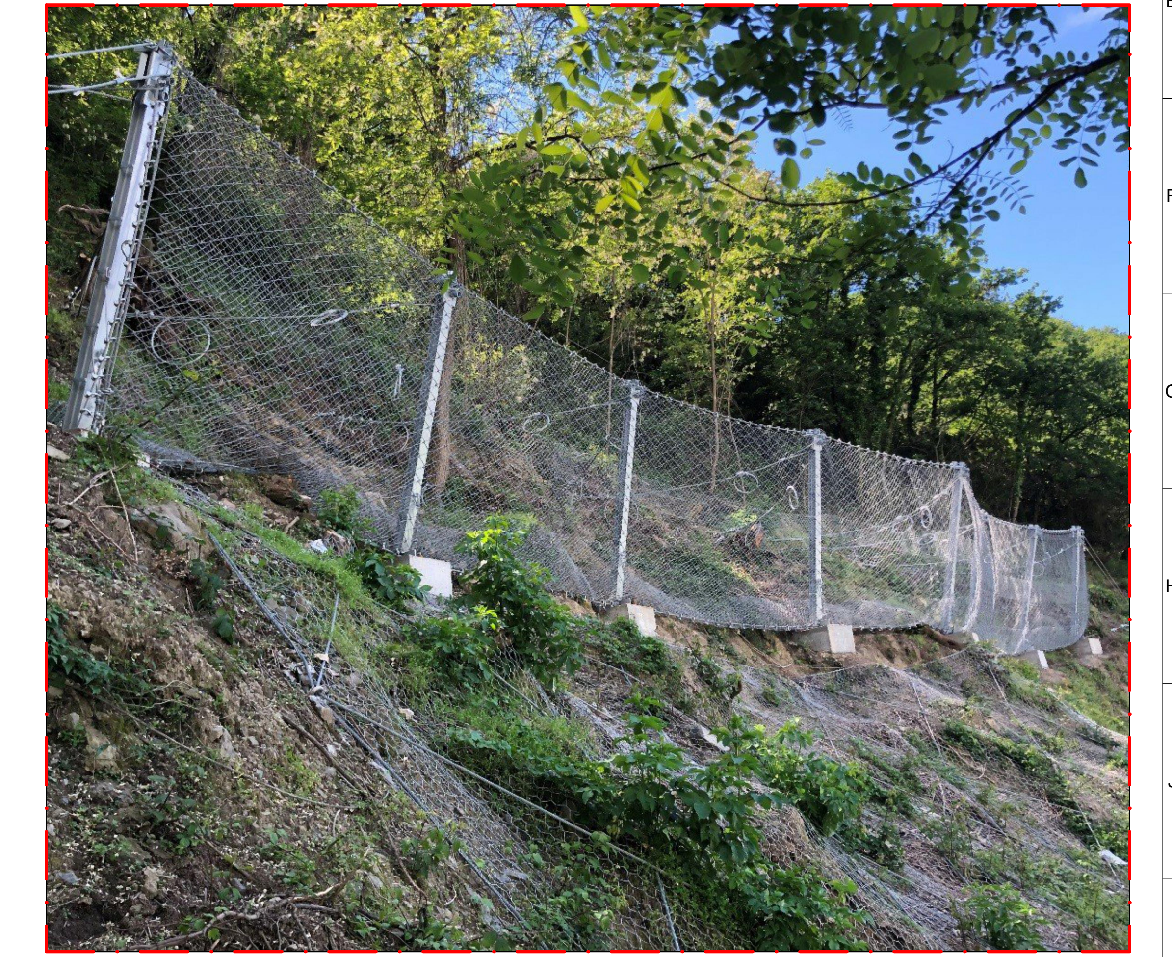
PARTICOLARE FOTOGRAFICO BARRIERA FRANGICOLATA - Rif. "Relazione dimensionamento barriera frangicolata"
