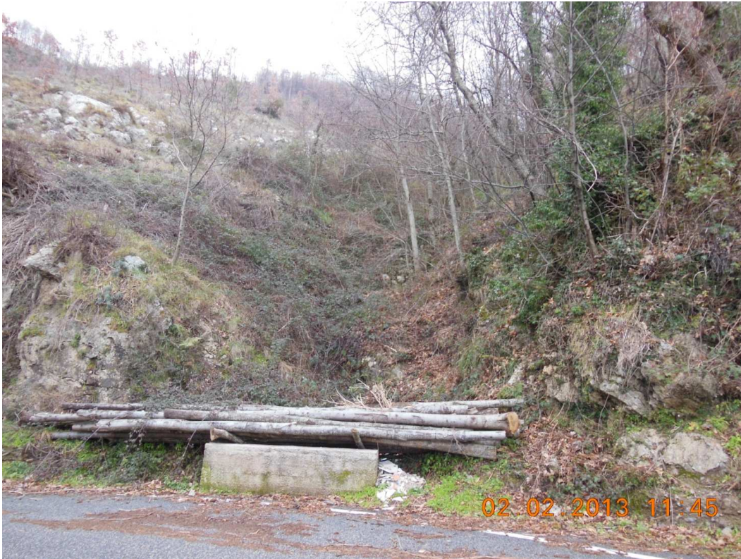
Foto 5: Fosso naturale nella successione lapidea in asse con l'area delimitata come “Colata estremamente rapida di fango”
