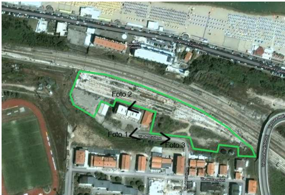
Figura 24 – Vista aerea del CA21. Per le viste fotografiche indicate in Figura si rimanda alla specifica relazione di cantierizzazione L03202R53RGCA0000001A
