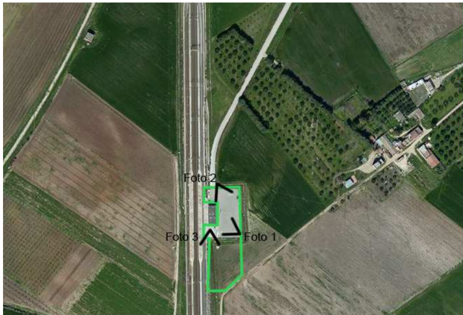
Figura 17 –Vista aerea del CA11. Per le viste fotografiche indicate in Figura si rimanda alla specifica relazione di cantierizzazione L03201R53RGCA0000001A
