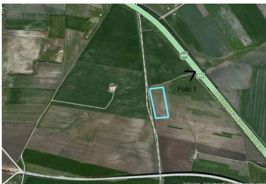
Figura 21 –Vista aerea del AS12. Per le viste fotografiche indicate in Figura si rimanda alla specifica relazione di cantierizzazione L03201R53RGCA0000001A
