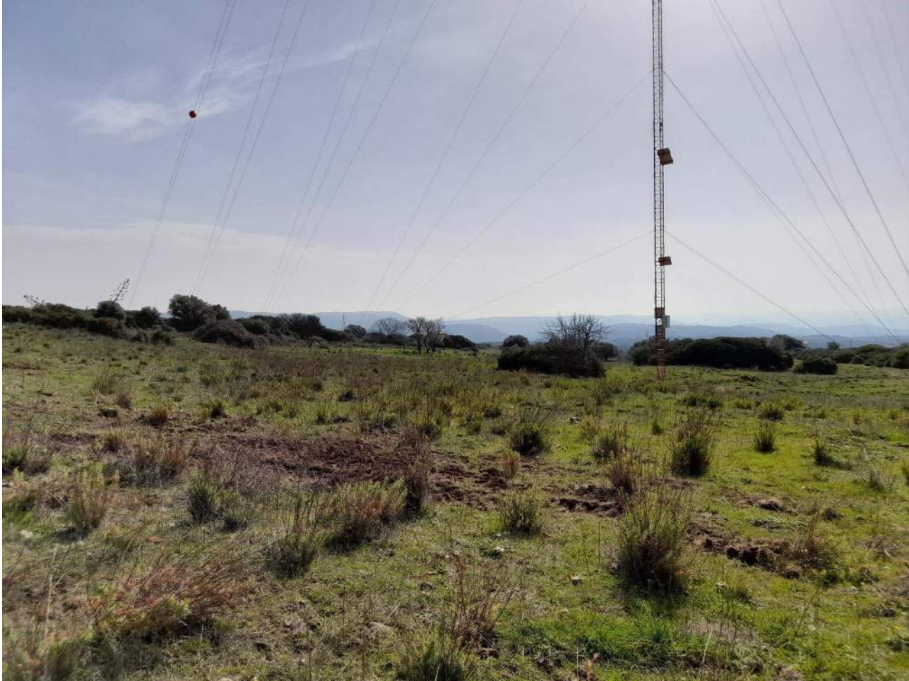
Figura 78 - UR10, AG10: vista verso SE
