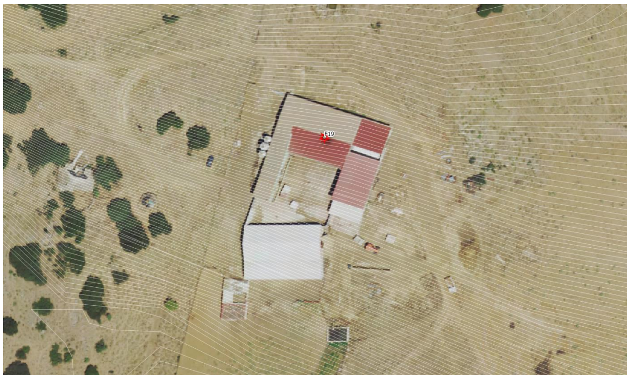
Figura 8.3 – Edificio F19 ed isolinee d'ombra proiettate dall'aerogeneratore AG05 (vista zenitale). Si noti come l'ombra, proveniente esclusivamente dal lato ovest, investe una porzione del fabbricato ragionevolmente funzionale all'esercizio di attività produttive, trovandosi la porzione residenziale sul lato est (cfr. Figura 8.4)
