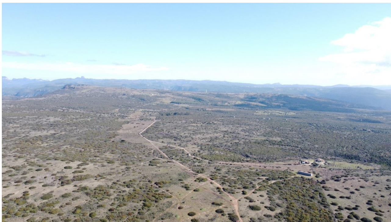
Figura 7.7 - Vista sulla porzione settentrionale e centrale dell'area di impianto. È visibile la caratteristica forma del tacco e i suoi confini. Ripresa aerea da ovest verso est nei pressi della postazione AG01
