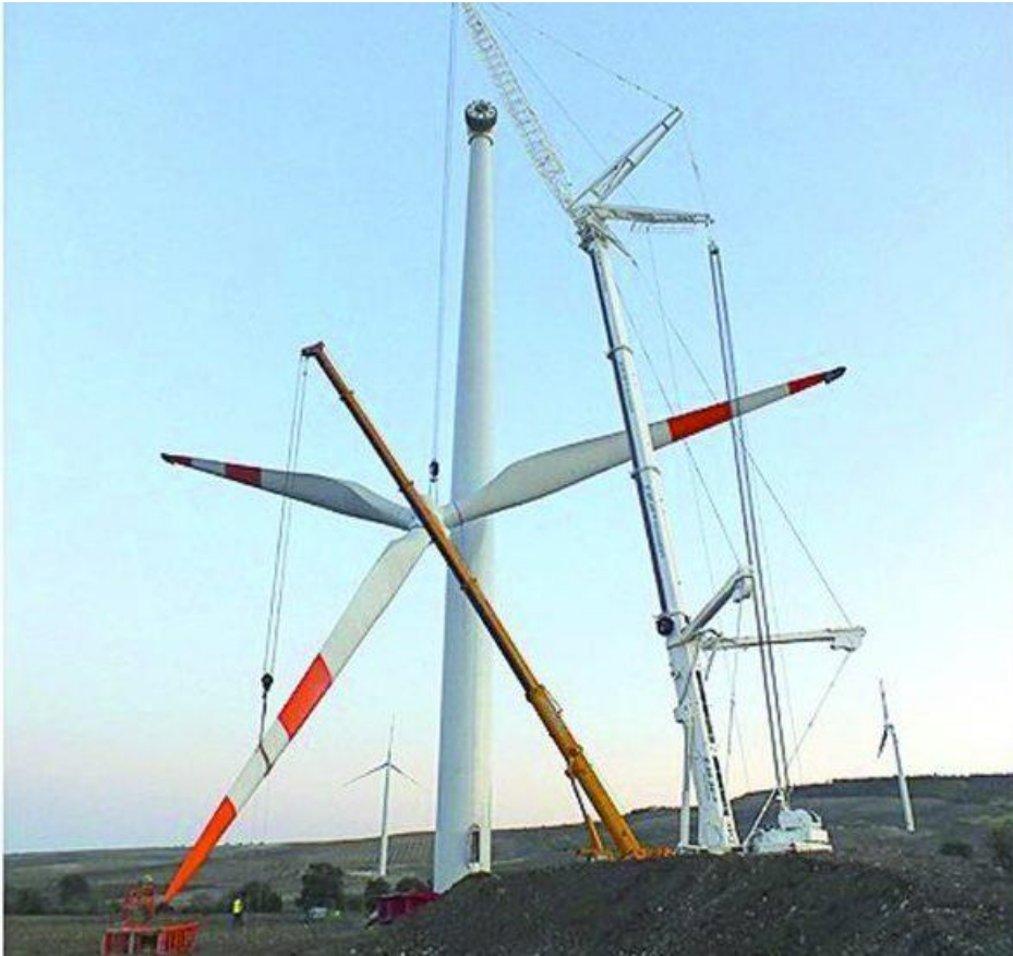
Figura 5.4 - Fase di montaggio dell'aerogeneratore
