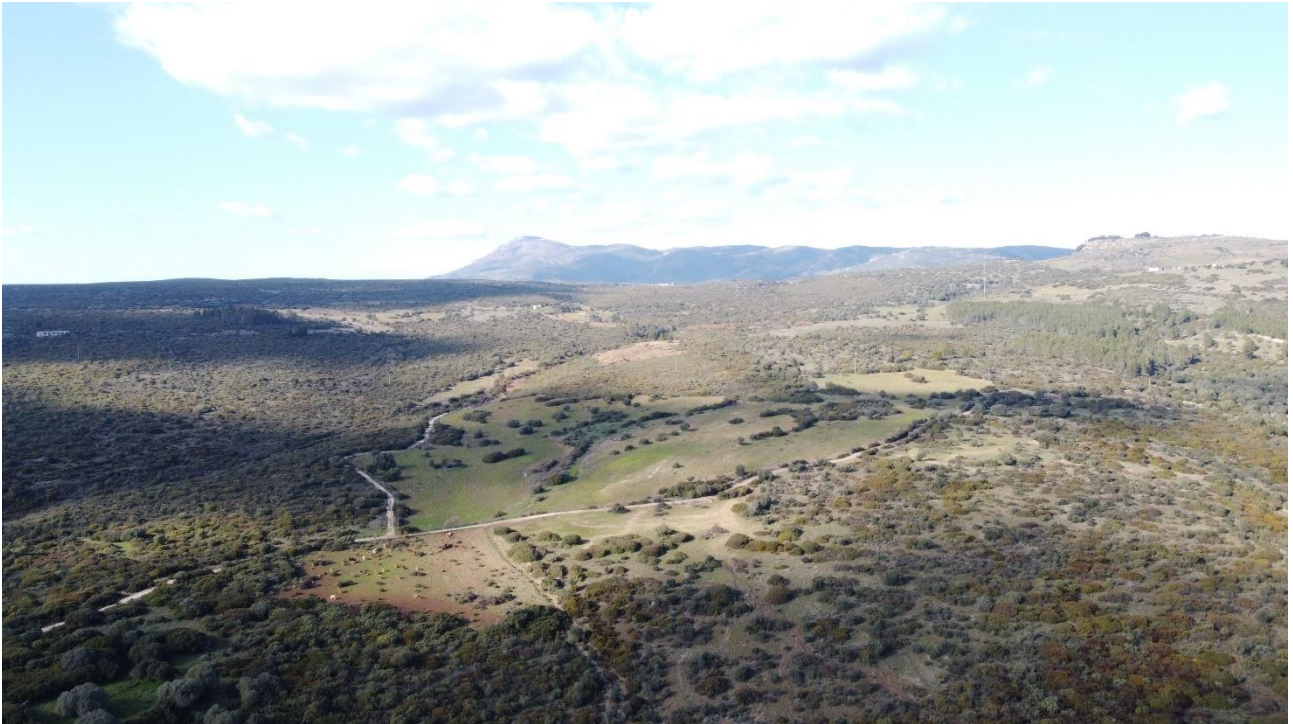
Figura 7.9 - Vista della porzione centro-settentrionale dell'area di impianto. Sullo sfondo la cima del Monte Vittoria (Esterzili). Ripresa aerea da sud-verso nord nei pressi della postazione AG06
