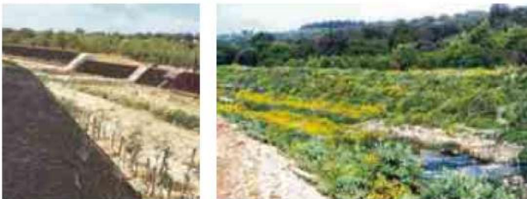
**Figura 9 - Sponde di una fiumara rivestite con geostuoia tridimensionale rinforzata e rinverdita.**
