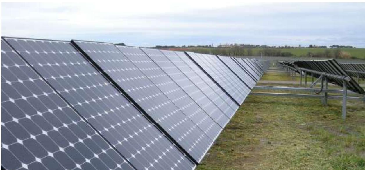
**Figura 14 - Stato del terreno inerbito sotto i pannelli fotovoltaici**
