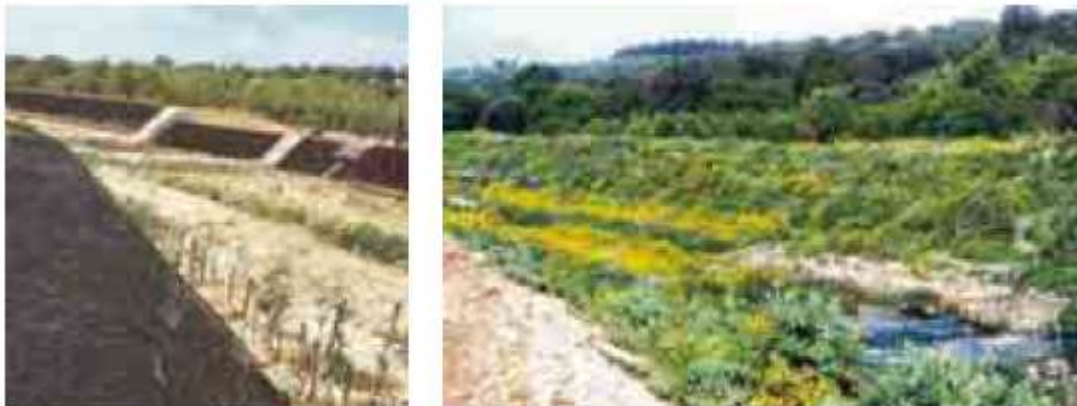
Figura 6 - Sponde di una fiumara rivestite con geostuoia tridimensionale rinforzata e rinverdata.
