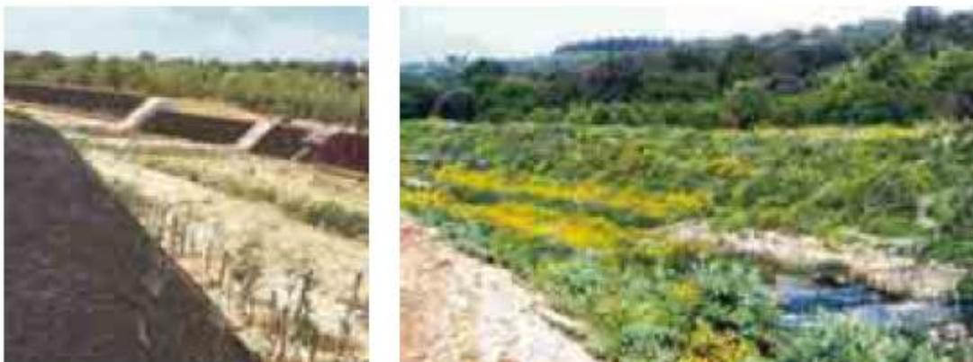
**Figura 6 - Sponde di una fiumara rivestite con geostuoia tridimensionale rinforzata e rinverdità.**
