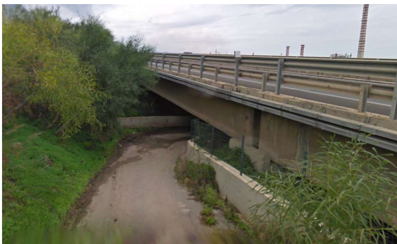
Fotografia 1 – Sottopasso alla A19.
