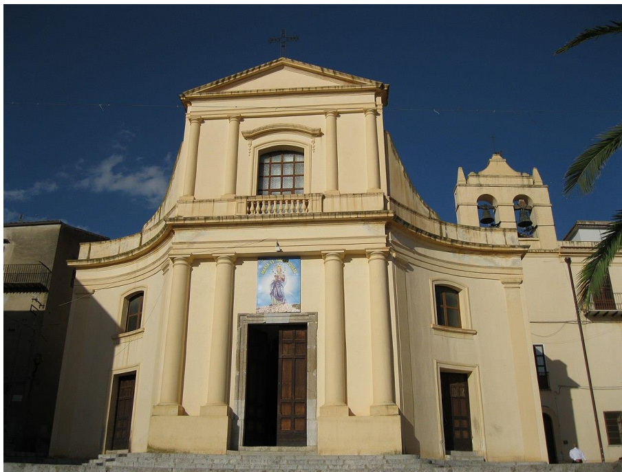
Facciata della Chiesa parrocchiale dedicata a Maria Santissima Immacolata
