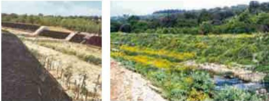
Figura 6 - Sponde di una fiumara rivestite con geostuoia tridimensionale rinforzata e rinverditata.
