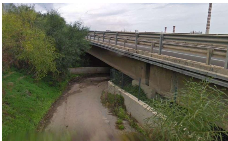
Fotografia 1 – Sottopasso alla A19.
