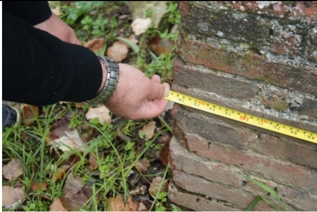
Rilievo Larghezza del pilastro in pianta
