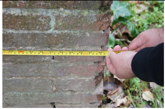
Rilievo profondità del pilastro in pianta
