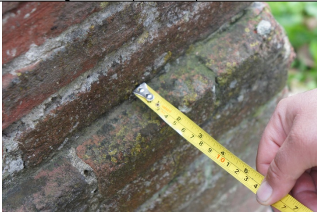
Rilievo riseghe 3-4 e 5 cm
