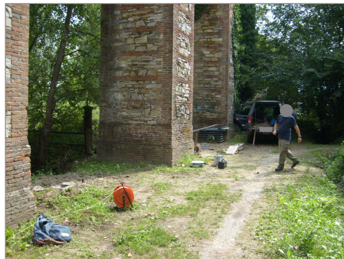
CH ERT: Vista da nord verso il pilastro indagato
