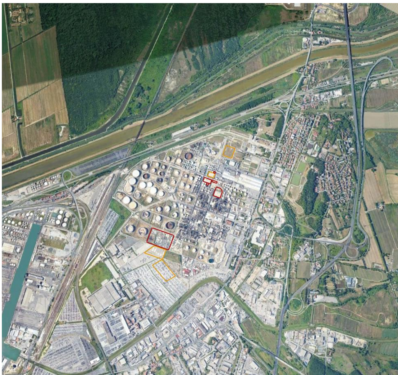
Figura 6.84 - Immagine satellitare del contesto oggetto di studio. Aree di progetto bordeaux (a nord PTU e UCO/RUCO, a sud Ecofining+SR) e relative aree di cantiere in arancione (Fonte: Google Eart)
