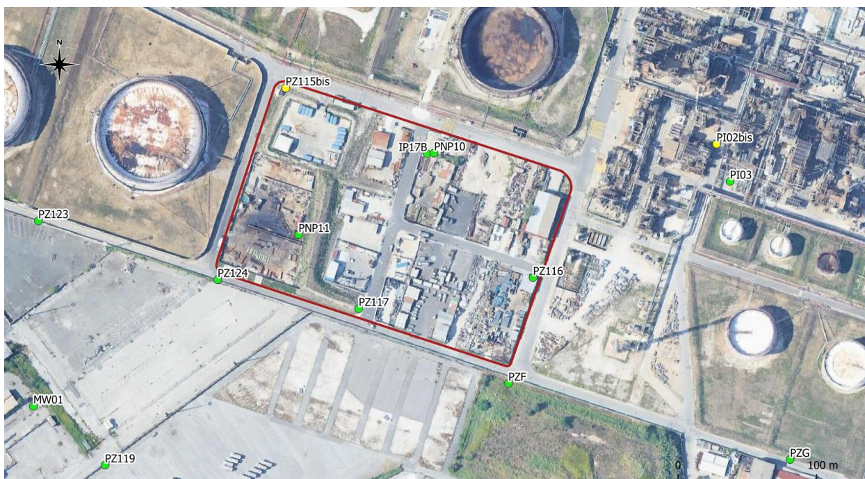
Figura 6.54: Piezometri di monitoraggio (gialli) e MISE (verdi) presso l'area Ecofining+SR.
