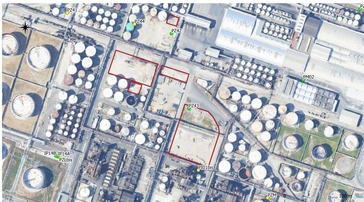
Figura 6.53: Piezometri di monitoraggio (verdi) e MISE (gialli) presso l'area EoW-PTU.
