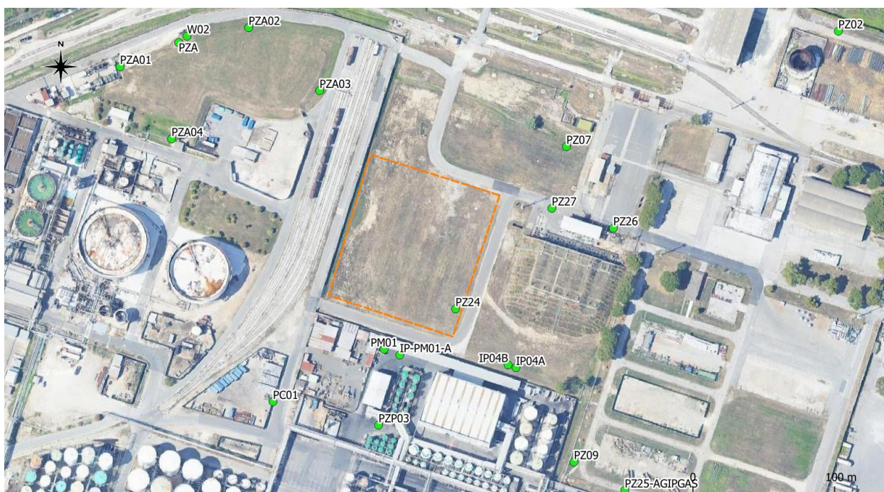
Figura 6.55: Piezometri di monitoraggio presso l'area di stoccaggio materiali di scavo EoW-PTU.
